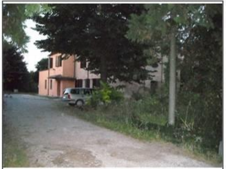
Vista da: Nord
