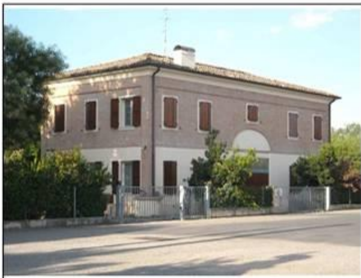
Vista da: Sud Ovest
