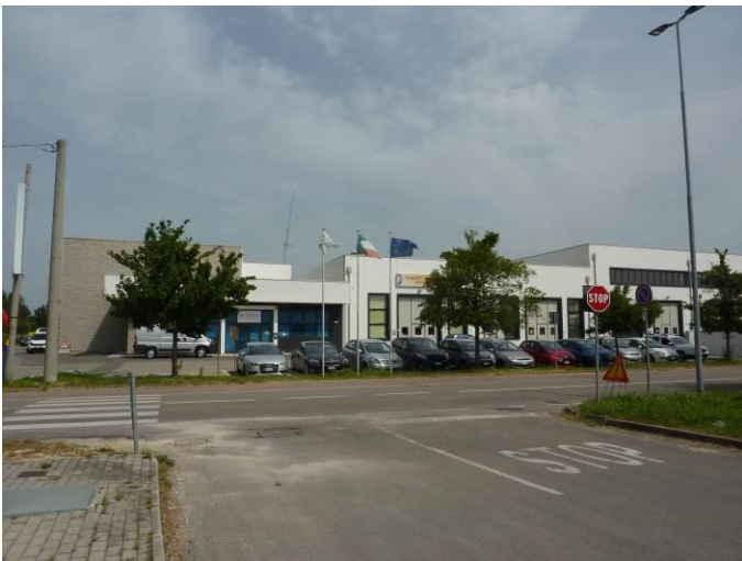
Vista da: Ovest
