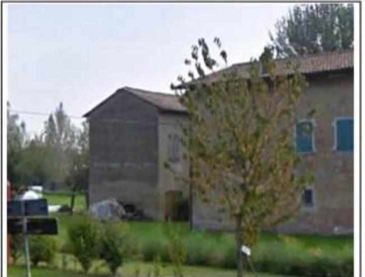
Vista da: Nord
