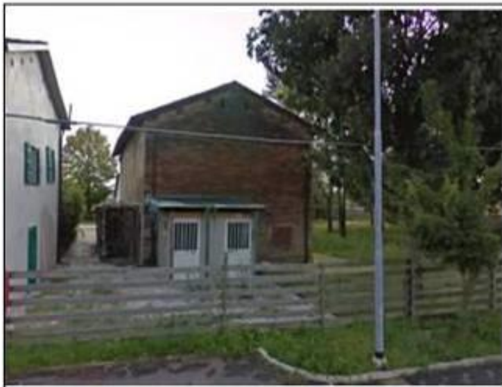
Vista da: Nord
