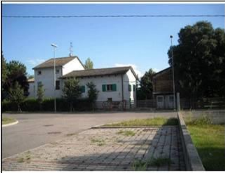
Vista da: Nord
