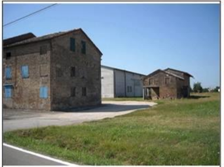
Vista da: Nord
