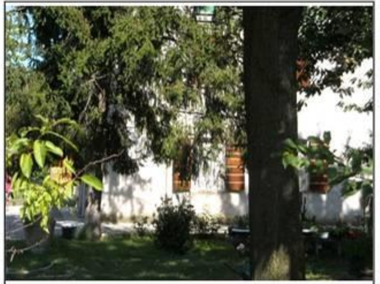
Vista da: Nord
