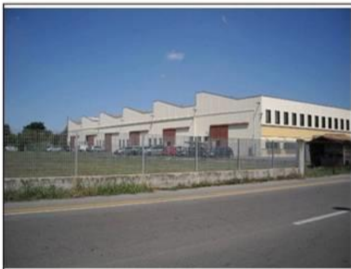
Vista da: Ovest
