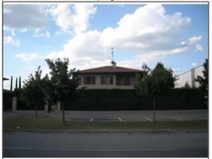
Vista da: Ovest
