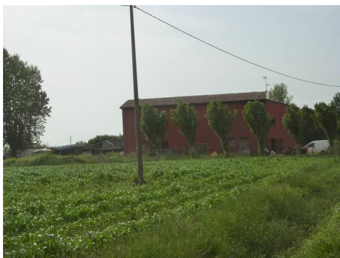
Vista da: Nord Est
