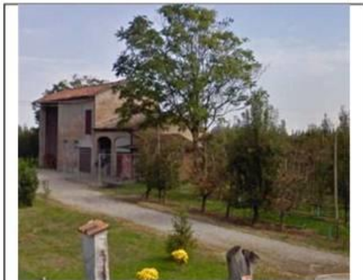
Vista da: Ovest
