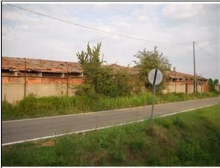
Vista da: Ovest
