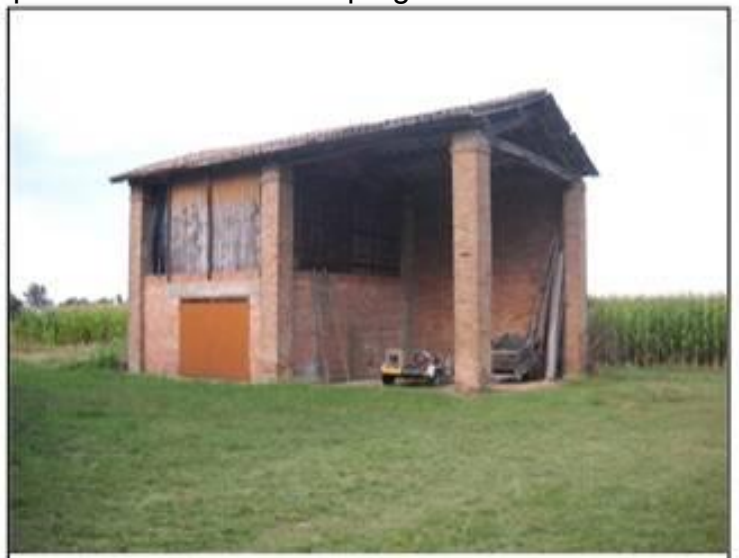
Vista da: Ovest
