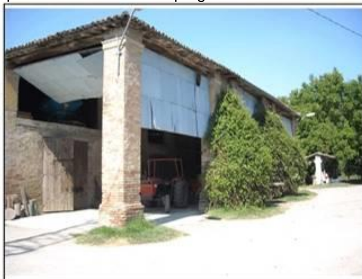
Vista da: Nord Est
