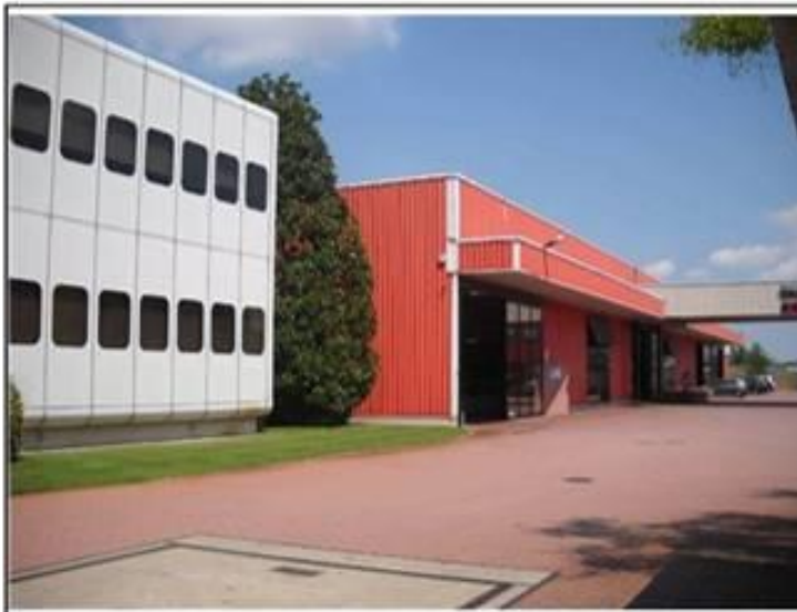
Vista da: Ovest
