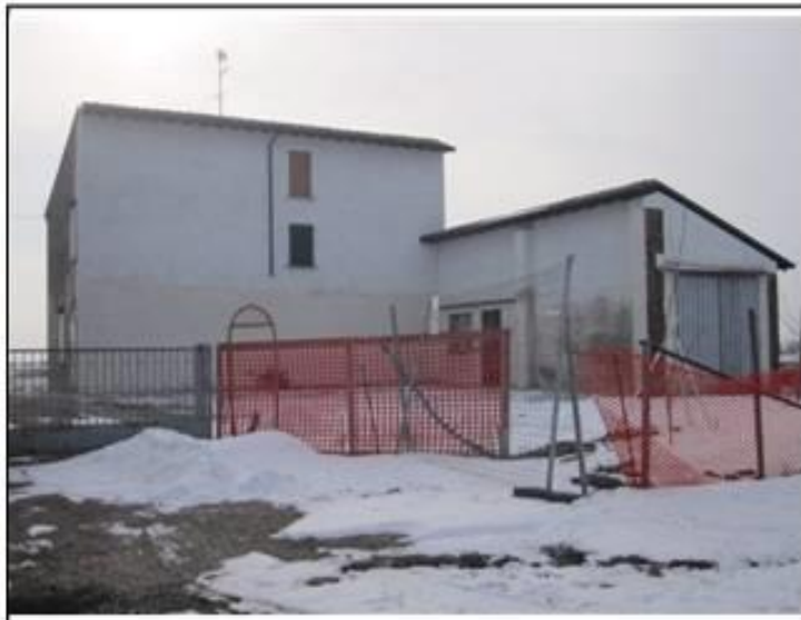
Vista da: Nord Est
