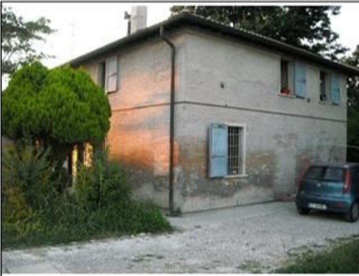
Vista da: Ovest
