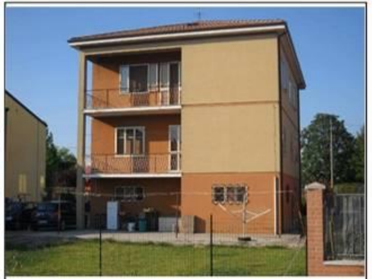
Vista da: Nord Est
