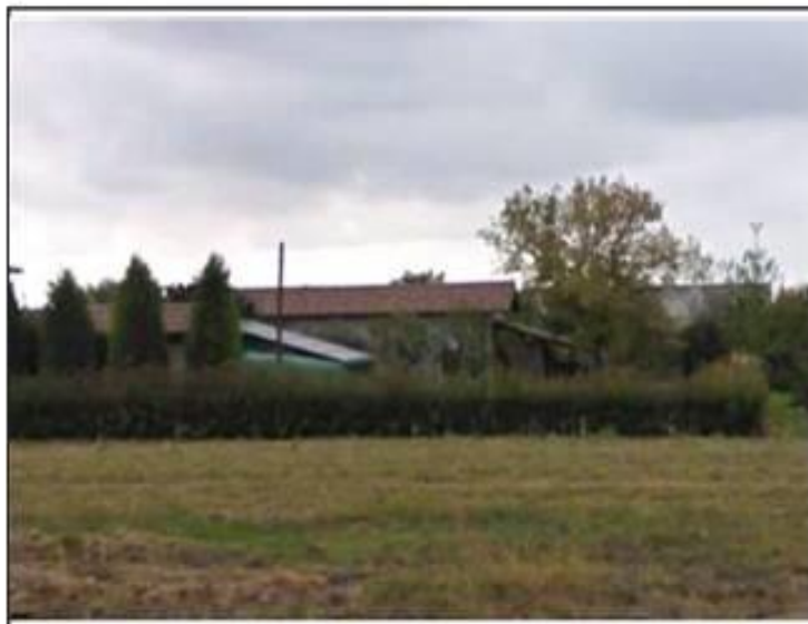
Vista da: Ovest
