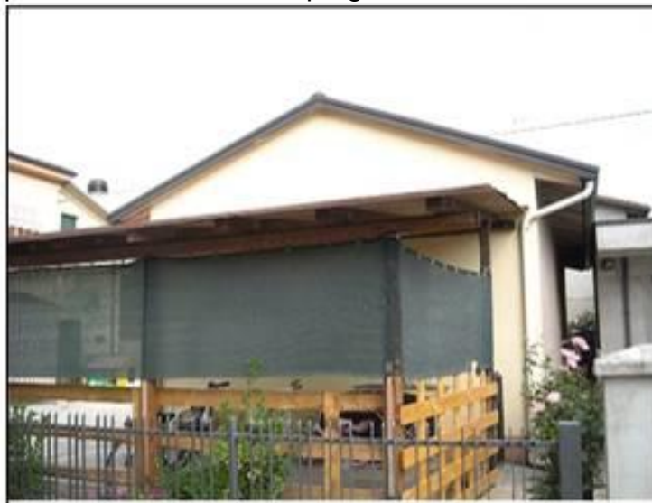
Vista da: Ovest
