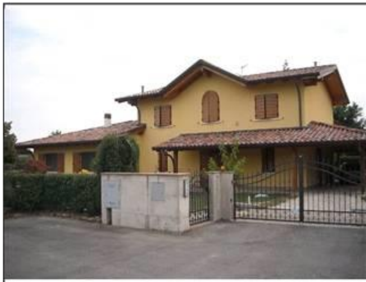
Vista da: Nord Est
