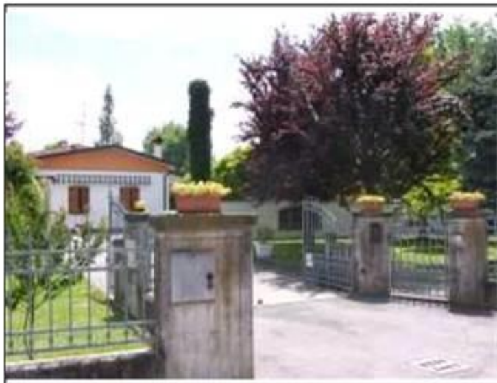
Vista da: Ovest
