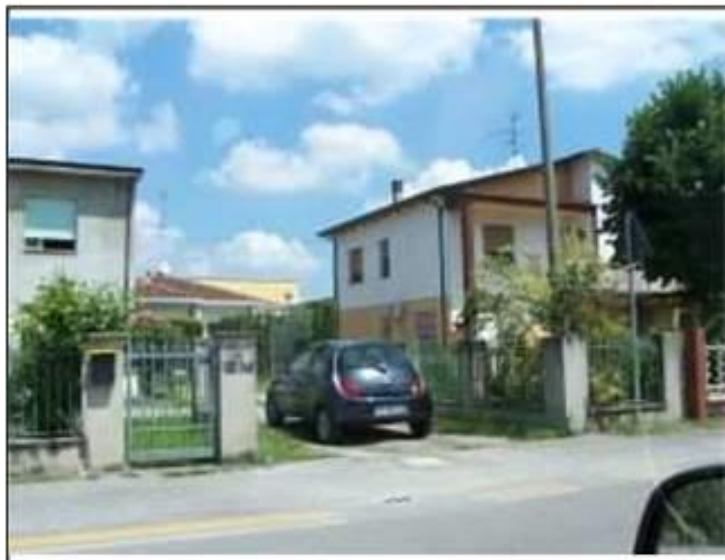
Vista da: Nord Est
