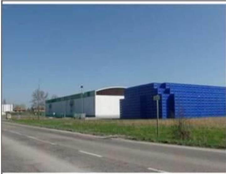
Vista da: Ovest
