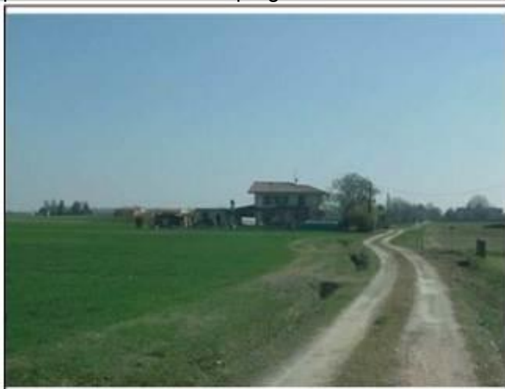
Vista da: Ovest
