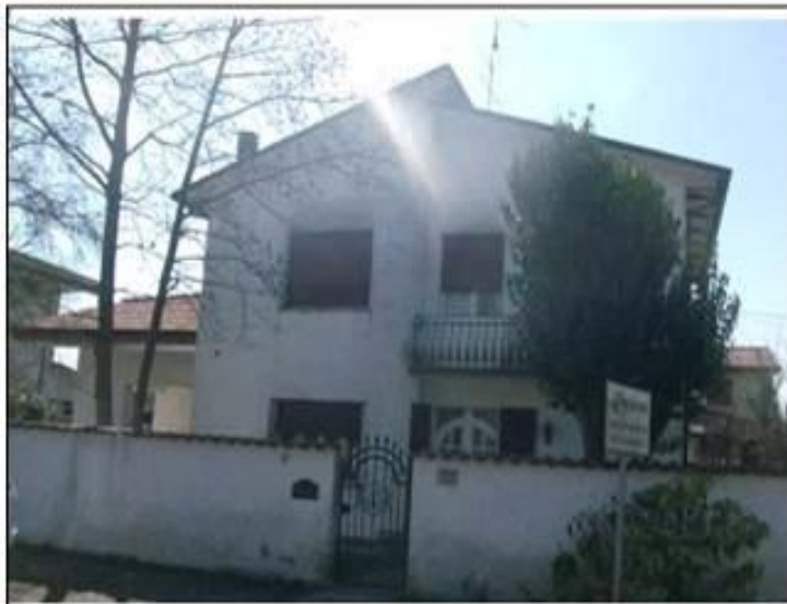
Vista da: Nord Est
