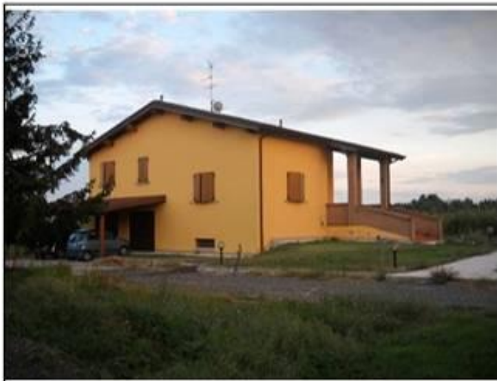
Vista da: Ovest
