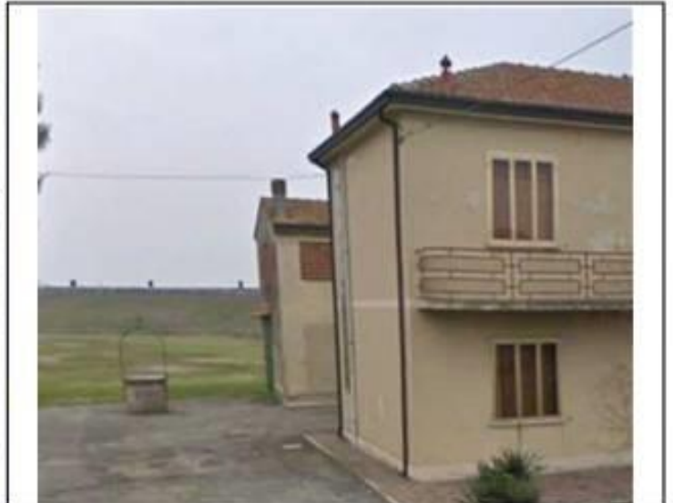
Vista da: Ovest
