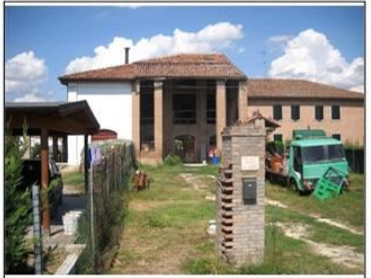
Vista da: Nord Est
