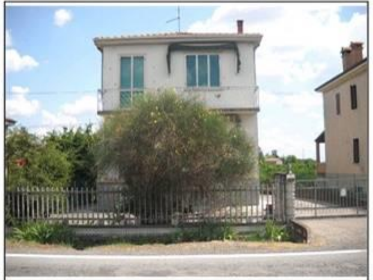
Vista da: Ovest
