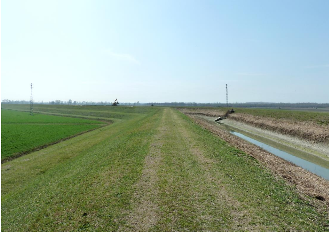
FIGURA 1-3 - CANALE BRESCELLO : STATO ATTUALE
