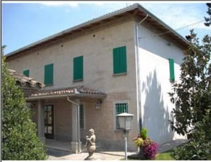
Vista da: Nord
