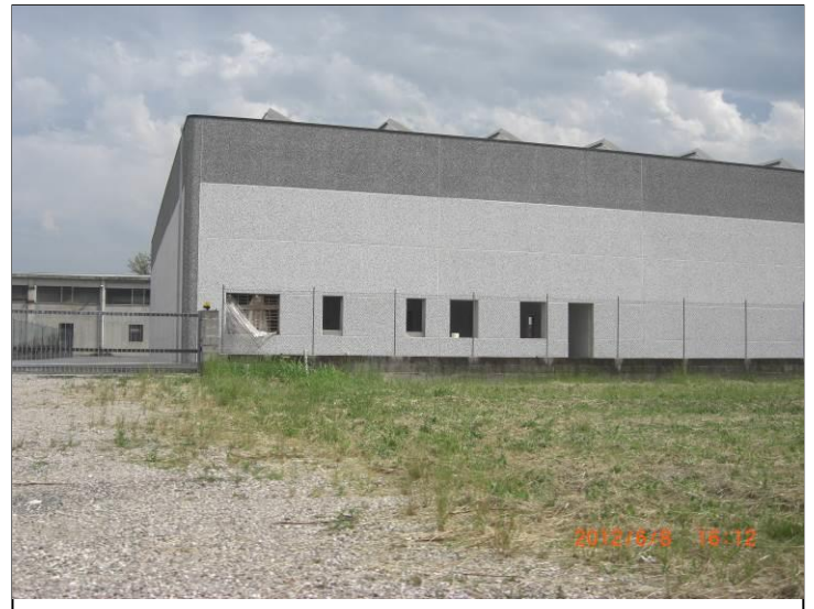
Vista da: Nord
