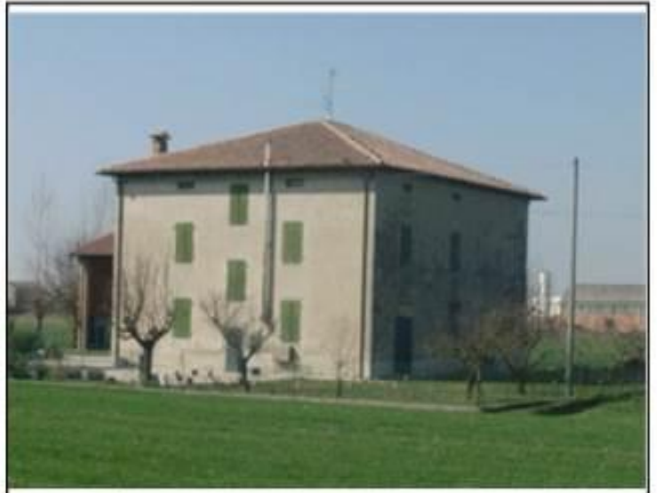
Vista da: Nord
