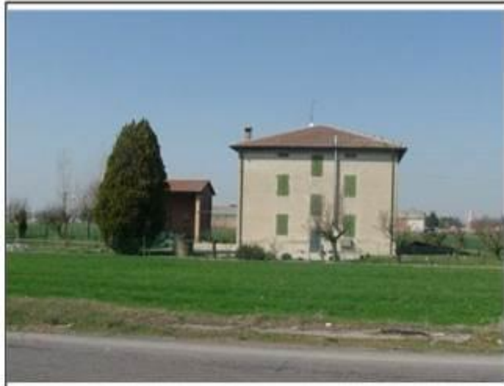
Vista da: Ovest
