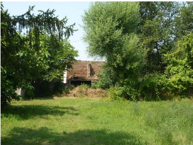
Vista da: Nord
