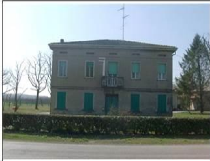
Vista da: Nord
