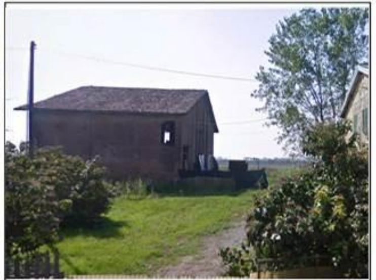
Vista da: Nord
