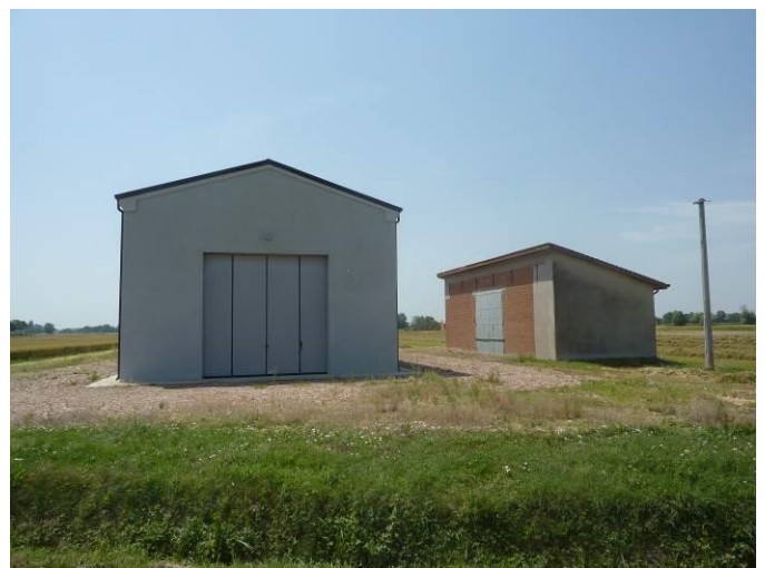
Vista da: Nord
