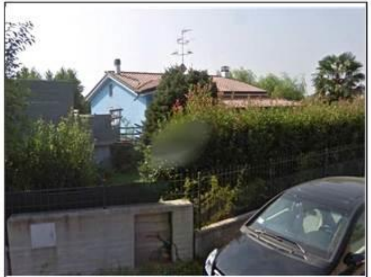
Vista da: Nord
