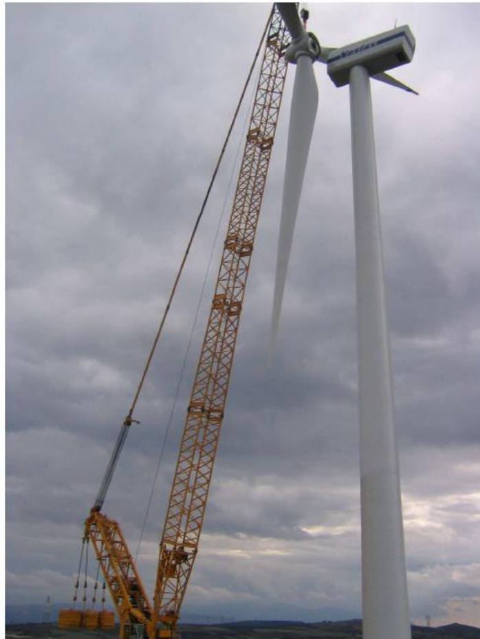
Figura 4 : Fase di montaggio dell'aerogeneratore
