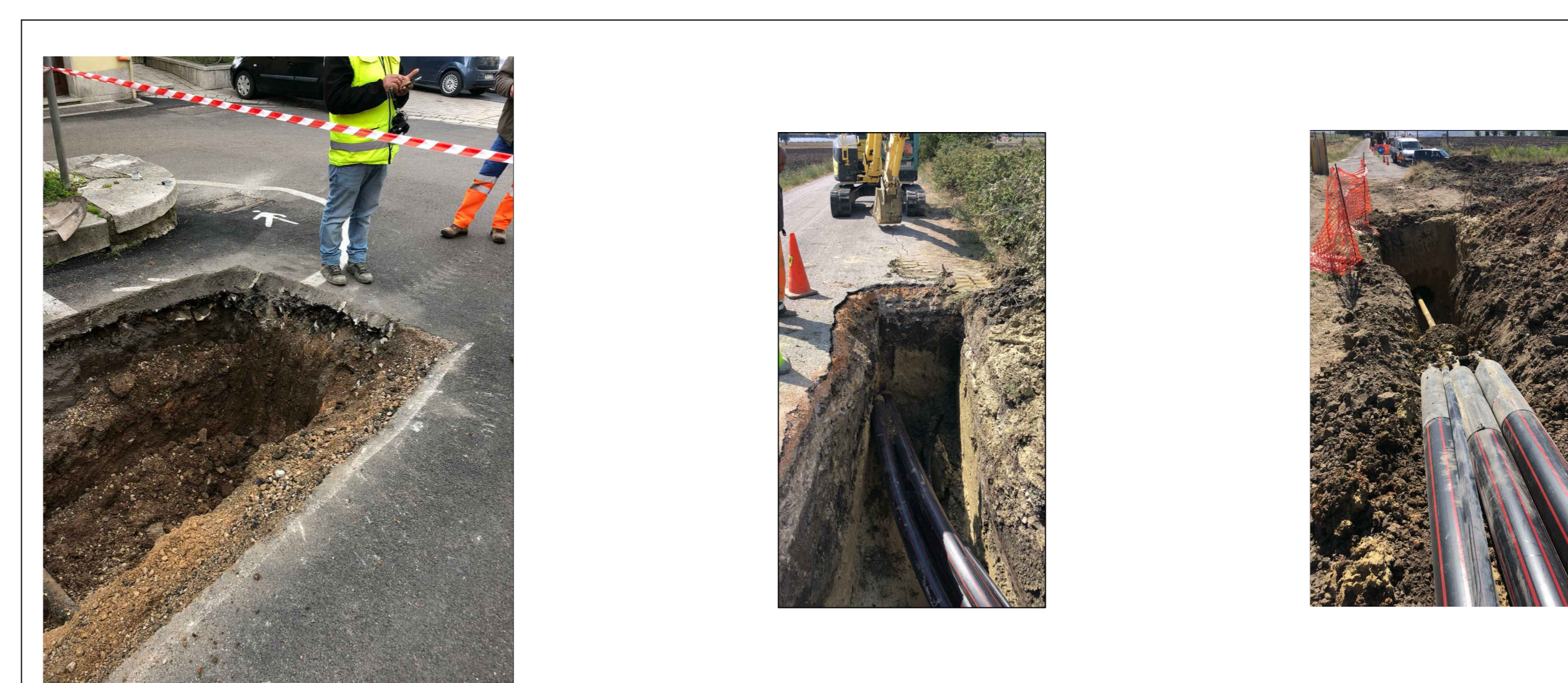
RIPRESE FOTOGRAFICHE INDICANTI IL FORO DI ENTRATA/USCITA DELLA T.O.C.
