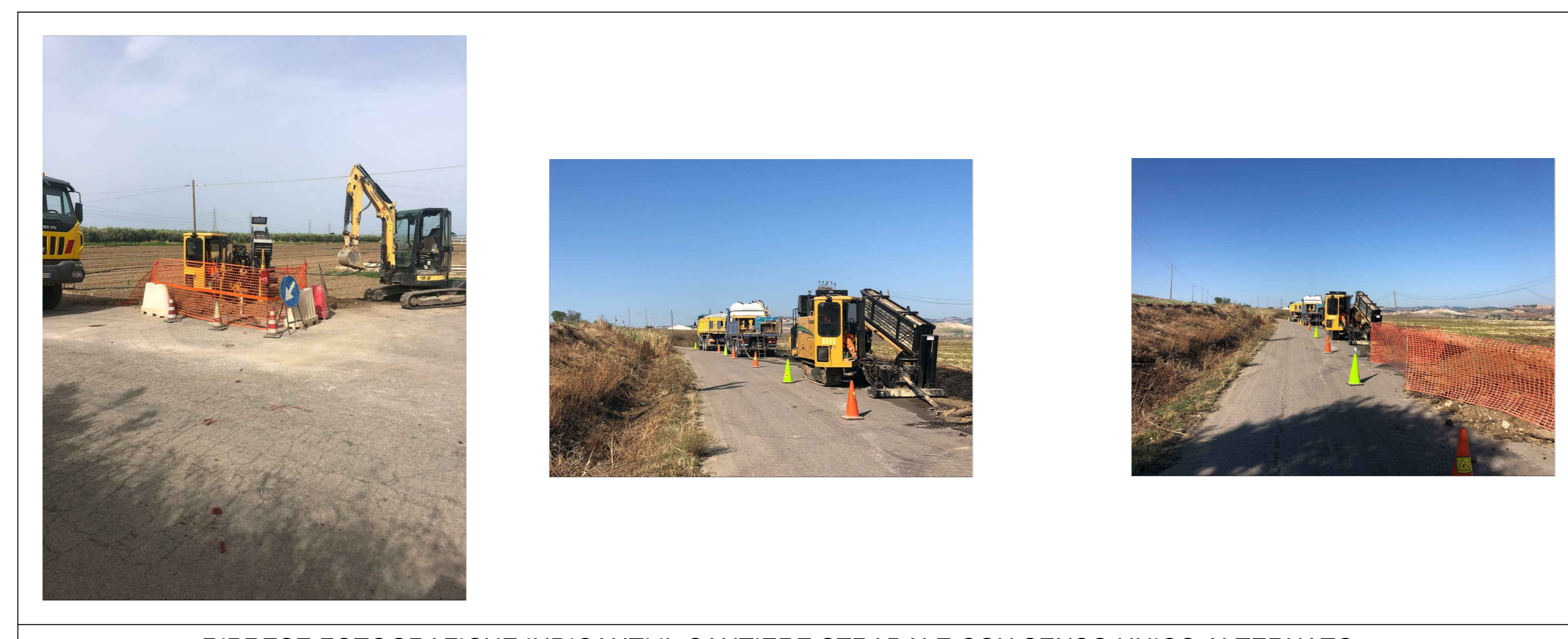
RIPRESI FOTOGRAFICHE INDICANTI IL CANTIERE STRADALE CON SENSO UNICO ALTERNATO
