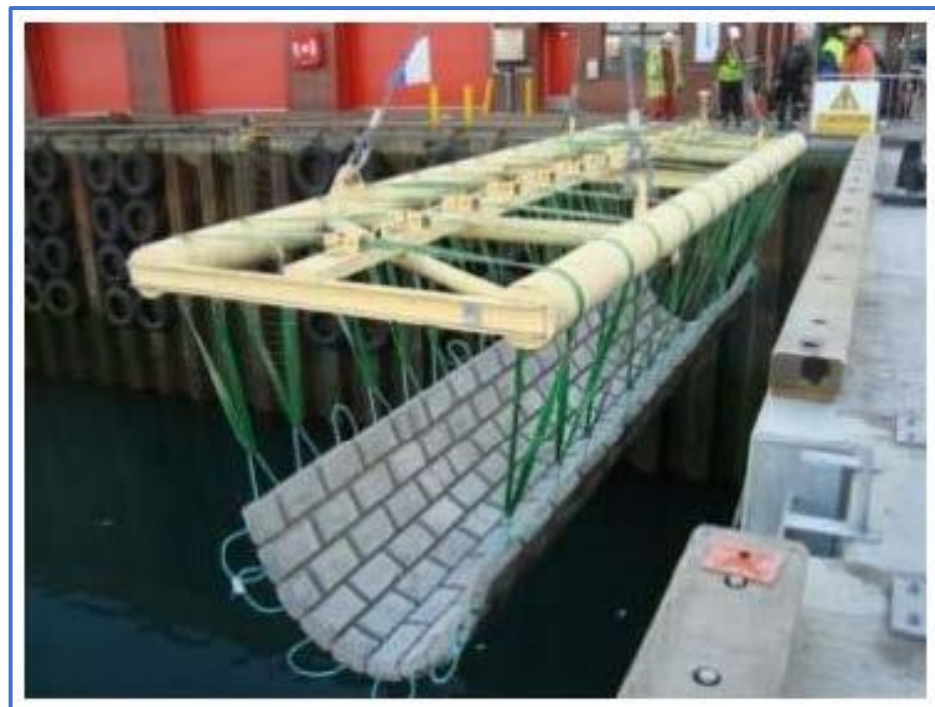
Figura 4-66 – Attraversamento dei cavi – Materassi in calcestruzzo tipico
