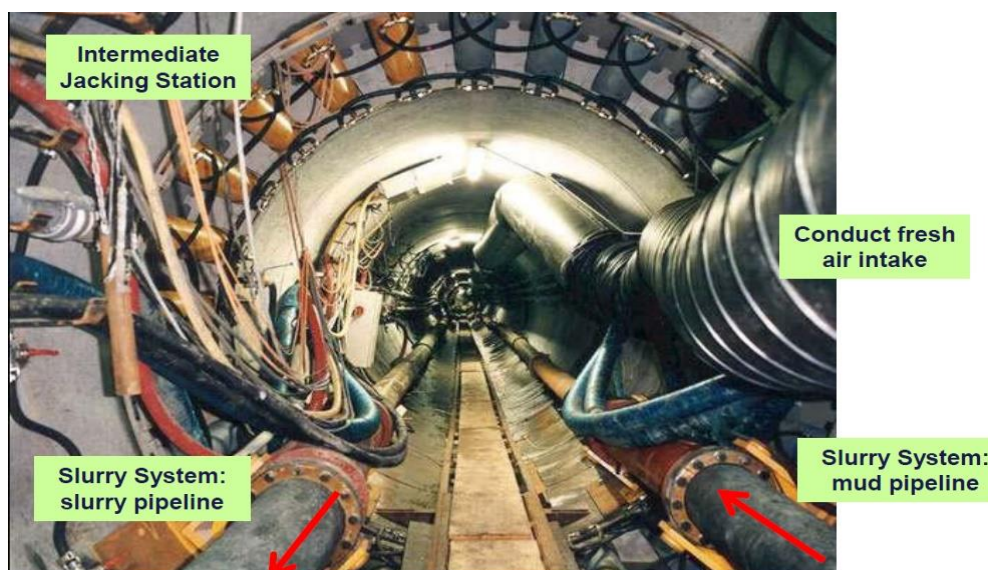
Figura 3-47 – Vista all'interno di un microtunnel durante la costruzione
