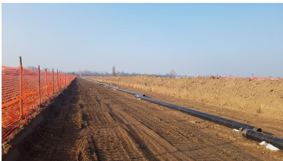
Figura 3-9 – Sfilamento dei tubi lungo la pista di lavoro
