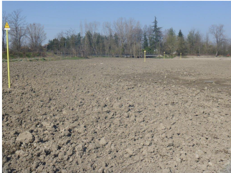
Figura 3-30 – Pista di lavoro su terreni agricoli dopo i ripristini
