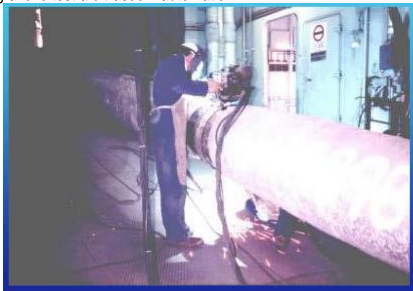
Figura 4-2 – Esempio di impianto automatico di saldatura – tipico
