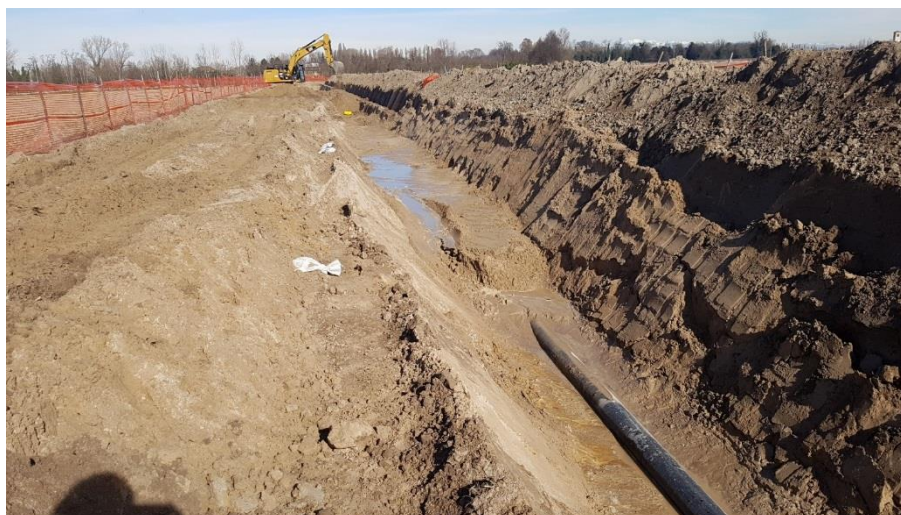
Figura 3-17 – Rinterro della condotta
