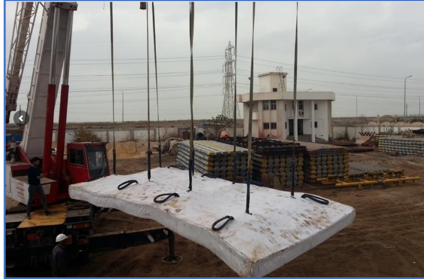
Figura 4-67 – Attraversamento dei cavi – Materassi bituminosi tipici
