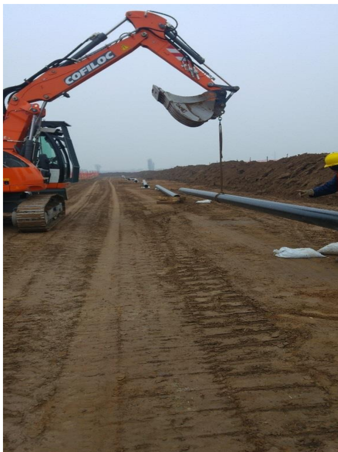
Figura 3-8 – Esempio di sfilamento dei tubi
