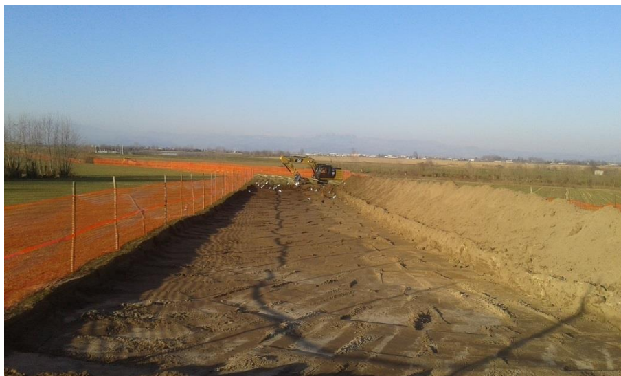
Figura 3-4 – Esempio di pista di lavoro
