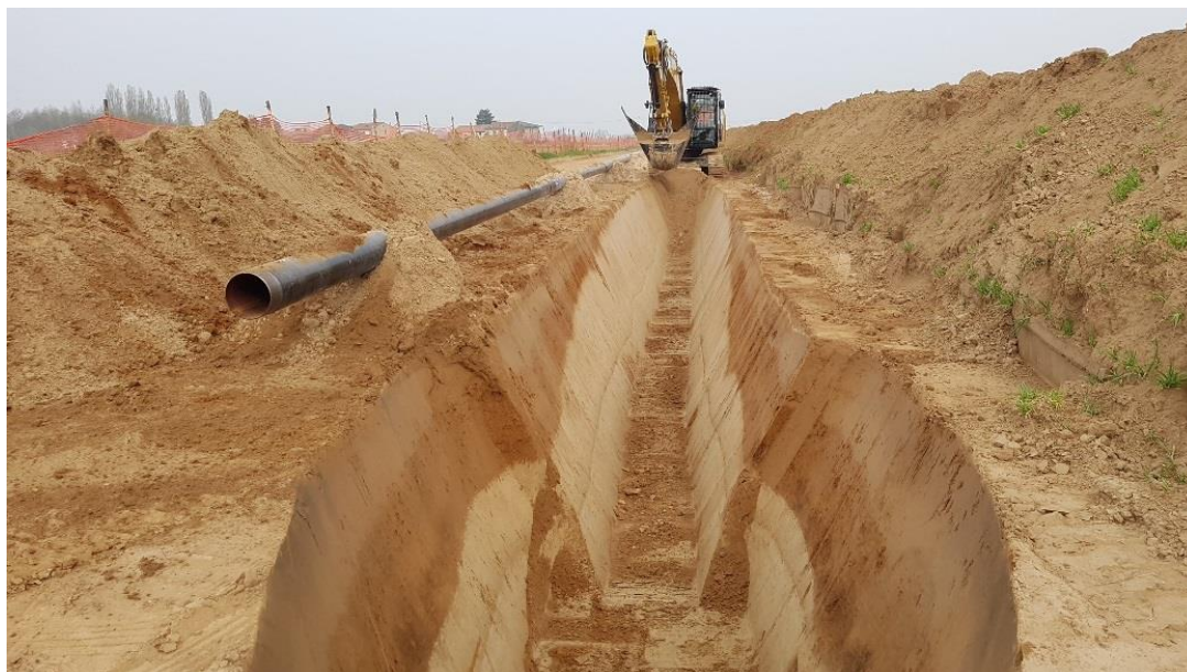
Figura 3-10 – Esempio di scavo di una trincea con terreni sciolti
