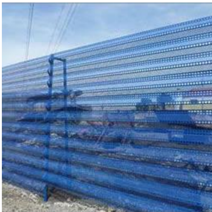
Figura 3-37 – Esempio di soppressione dalla polvere e schermo antivento
