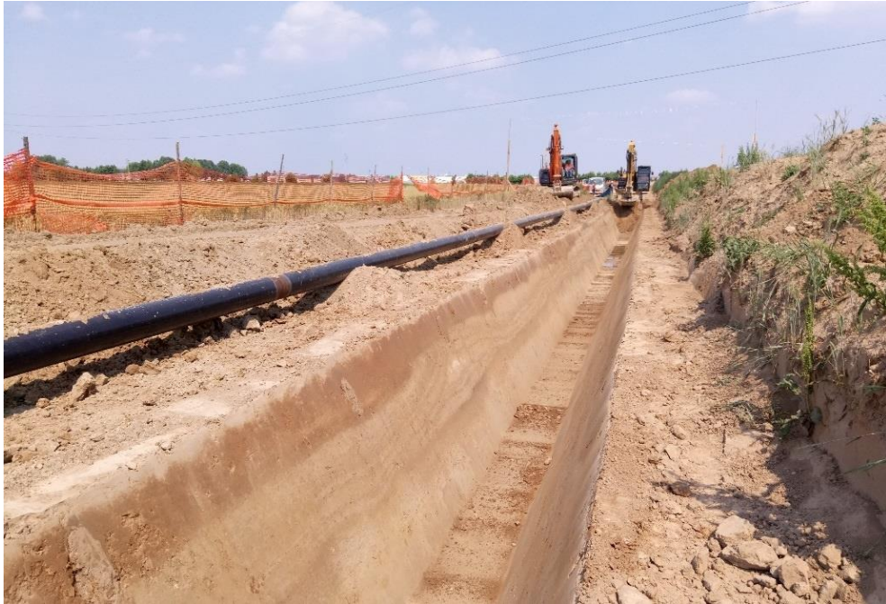
Figura 3-11 – Scavo della trincea con tubazioni saldate lungo la pista lavoro
