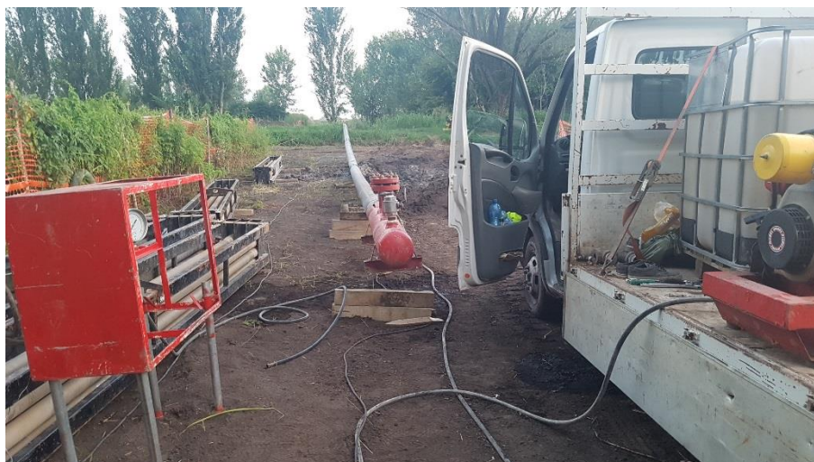
Figura 3-29 – Collaudo idraulico
