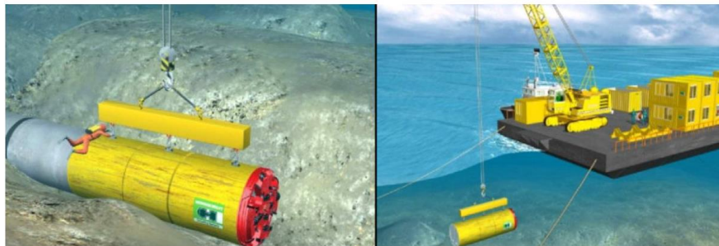
Figura 3-49 – Recupero della fresa meccanica a mare
