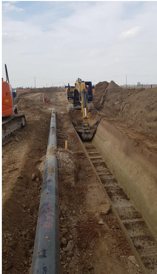
Figura 3-12 – Scavo della trincea con escavatore
