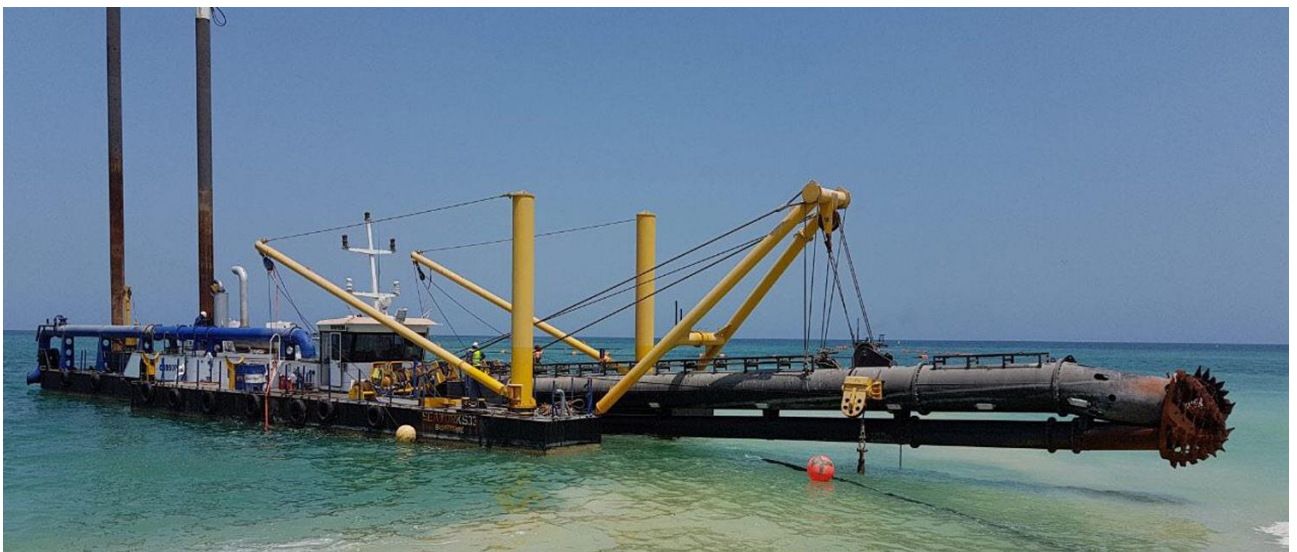
Figura 4-5 – Lavori di preparazione all'uscita a mare dell'TOC - Esempio di draga aspirante da taglio.
