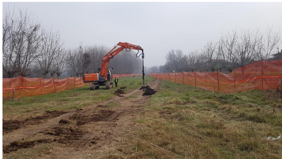
Figura 3-1 – Esempio di bonifica bellica lungo la ROW
