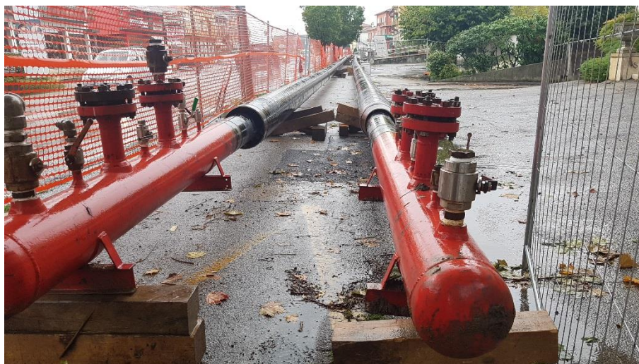
Figura 3-28 – Collaudo idraulico, piatti di prova
