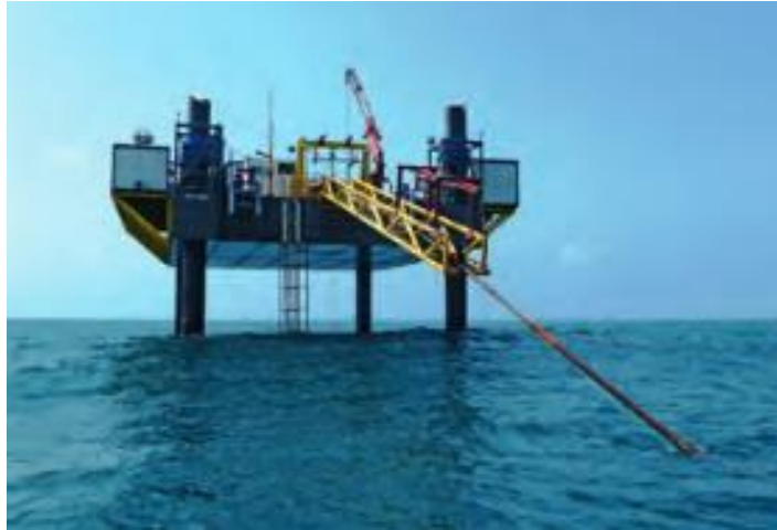
Figura 3-53 – Tipica chiatta per l'installazione offshore della postazione di spinta
