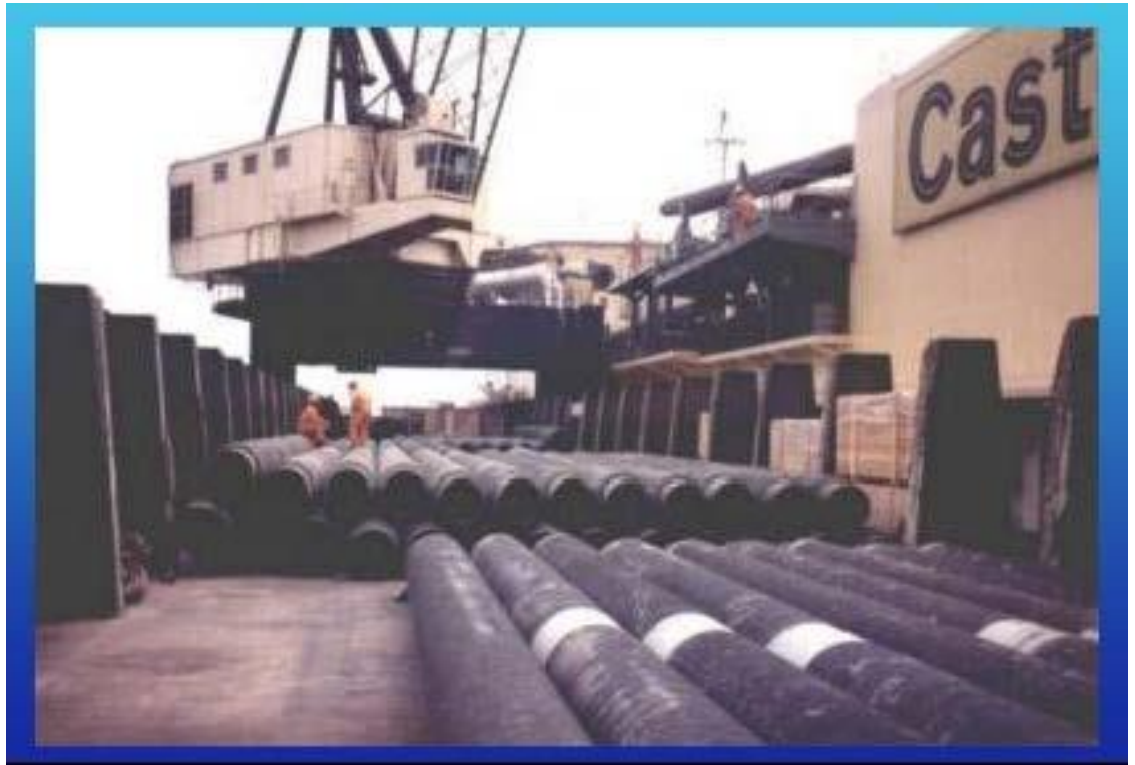
Figura 4-17 – Posa tubi “S-lay” - Tipica area di accatastamento a bordo dei tubi
