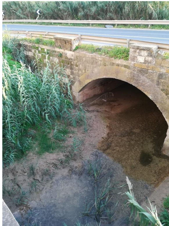
Foto 13 – Canale Priolo e S.S. n.155 vicino alla zona di attraversamento (KP 3+365)
