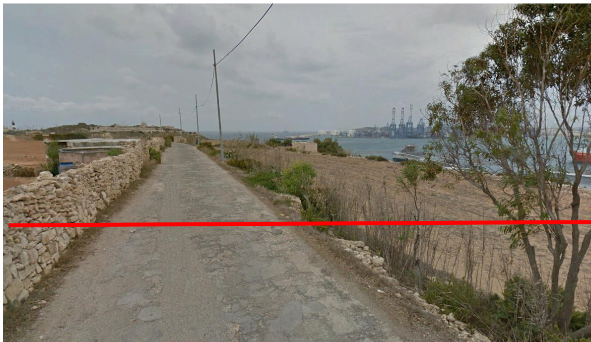
Foto 27 – Attraversamento “Triq Delimara” con tecnologia trenchless (Microtunnel) (159+190)
