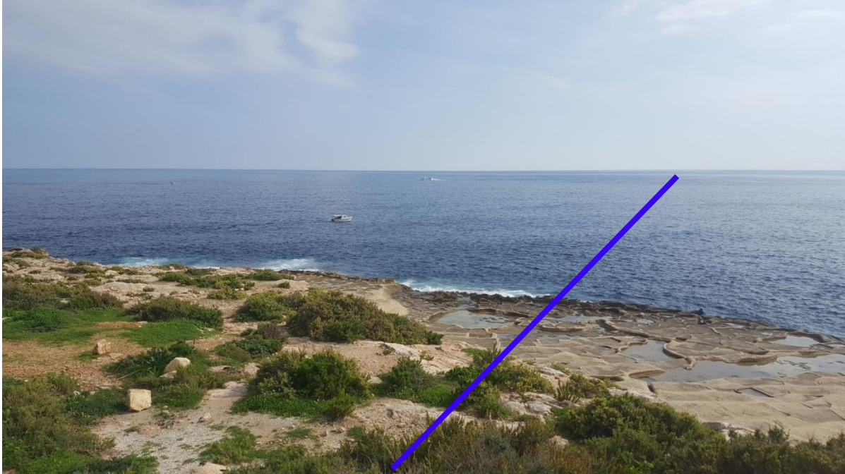
Foto 26 – Approdo con tecnologia trenchless (Microtunnel) (KP 158+610)
