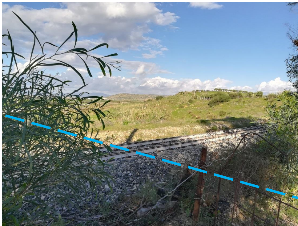
Foto 19 – Attraversamento Ferroviario “Canicattì-Siracusa” (KP 5+750)
