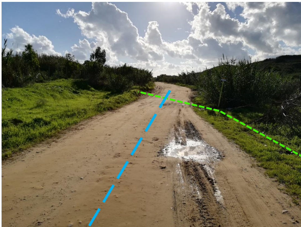
Foto 22 – Percorrenza sotto strada comunale e parallelismo con gasdotto SRG
