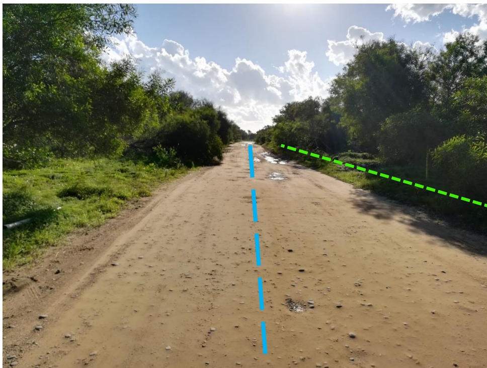
Foto 23 – Percorrenza sotto strada comunale verso la linea di costa (KP 6+390)
