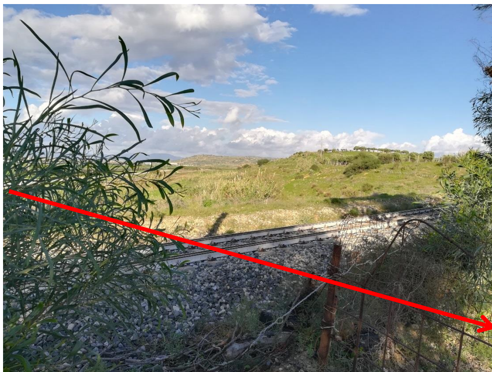
Foto 19 – Attraversamento ferroviario “Canicatti-Siracusa” (KP 5+750)
