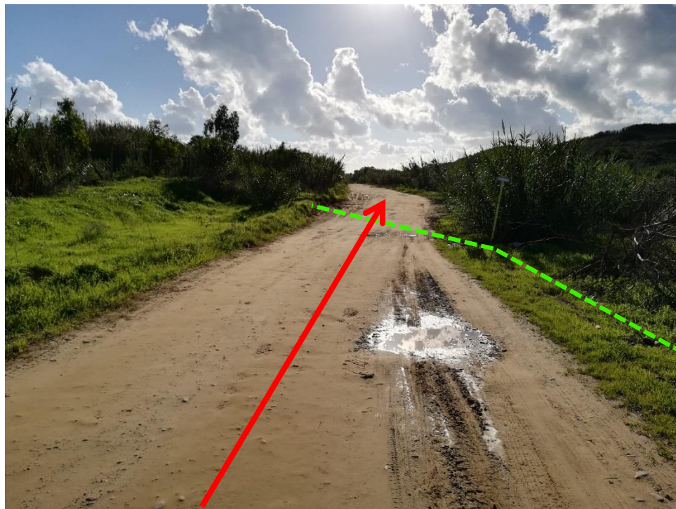
Foto 22 – Percorrenza sotto strada comunale e parallelismo con gasdotto SRG All. "Le Serre" di Gela DN 150 – 75 bar (KP 6+120)
