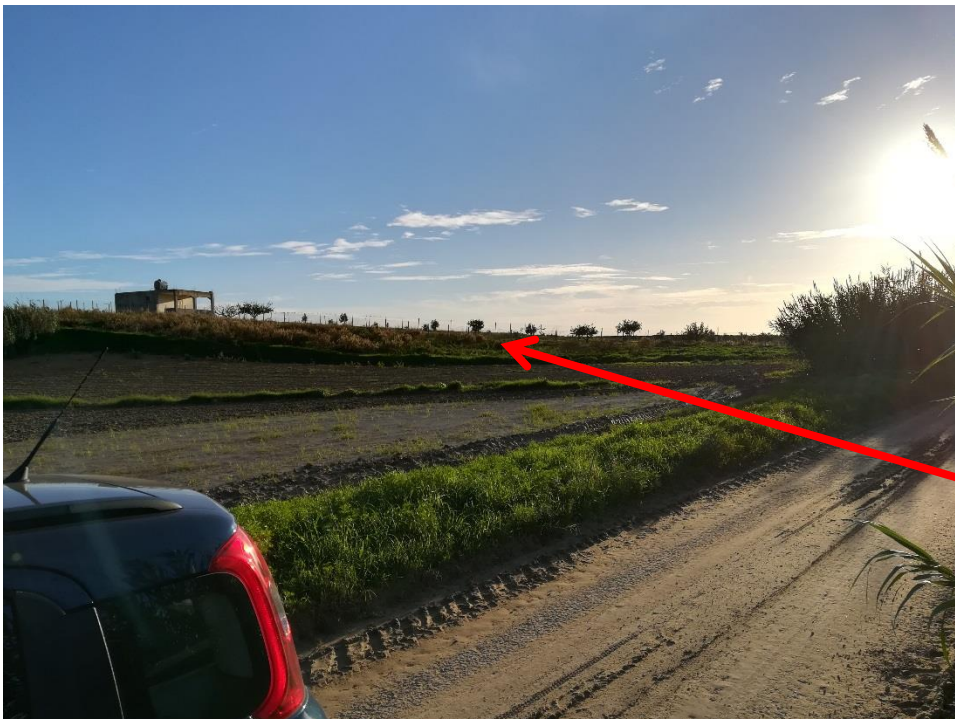
Foto 2 – Attraversamento strada provinciale n.82 (KP 0+105)
