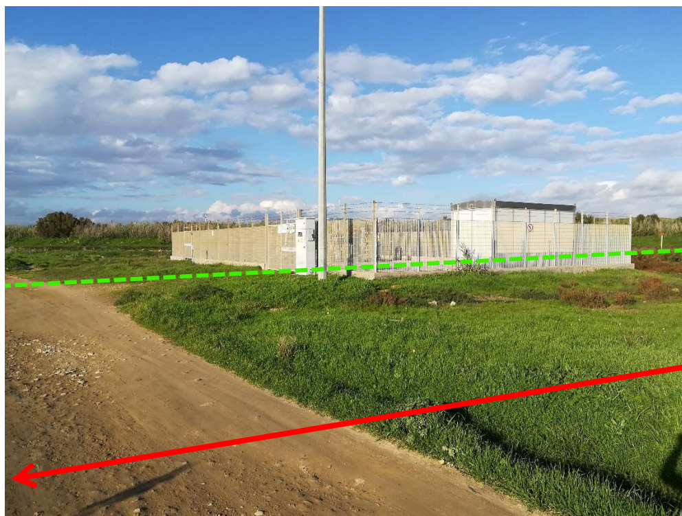
Foto 18 – Parallelismo vicino all'impianto SRG e gasdotto Gela-Enna DN 900 – 75 bar (KP 5+000)
