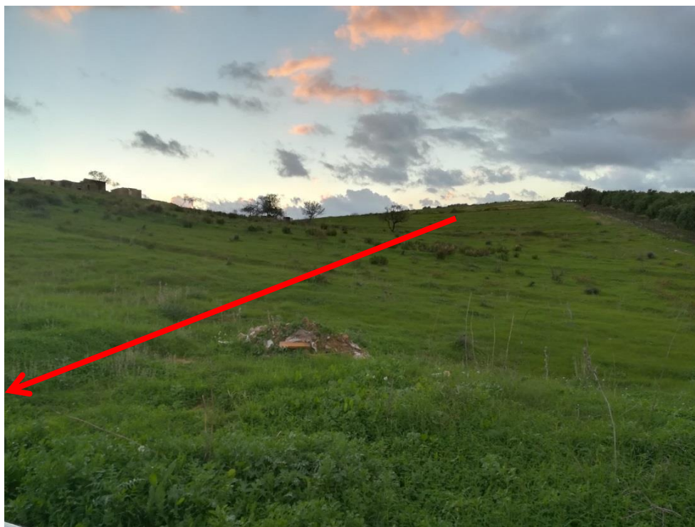
Foto 7 – Tracciato che risale la collina in TOC (KP 2+500)
