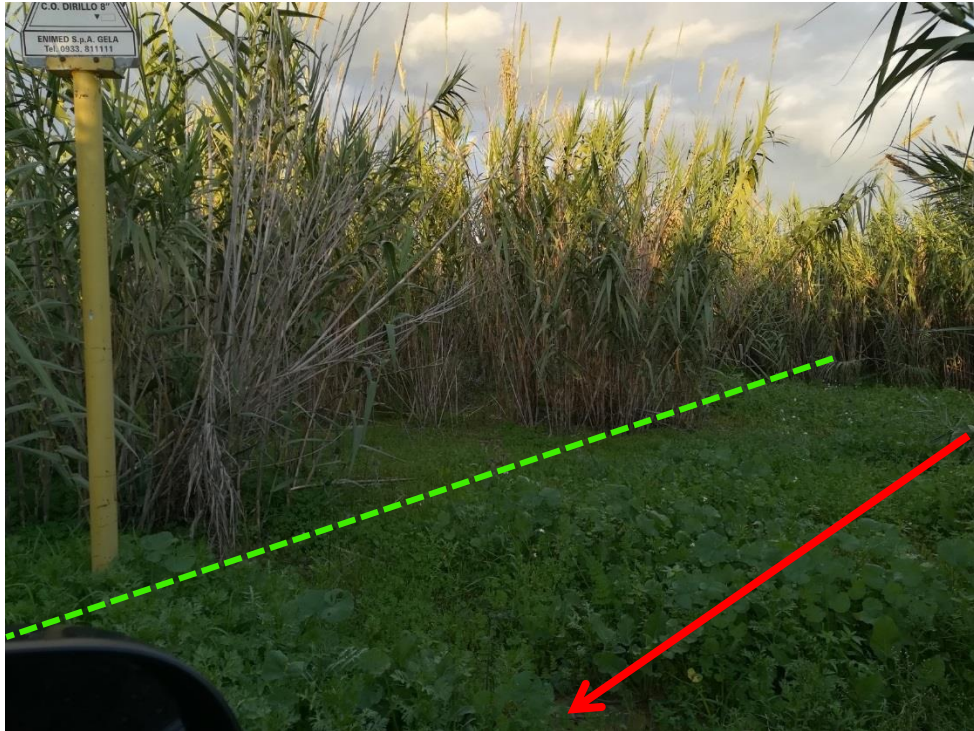
Foto 11 – Tratto in parallelismo con l'oleodotto tra la ferrovia e l'attraversamento Canale Priolo (KP 3+240)
