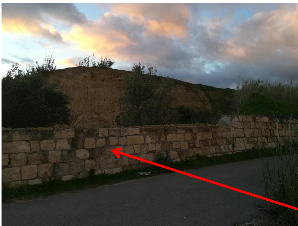
Foto 8 – Attraversamento della strada comunale in cima alla collina (KP 2+700)
