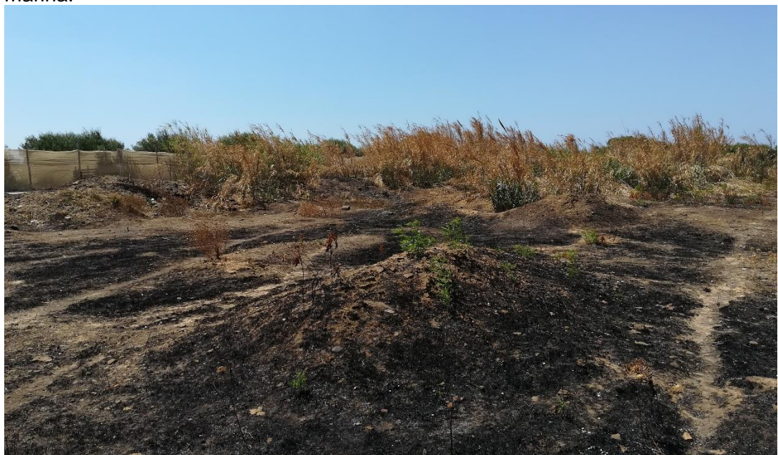
Figura 3-5: Vista del punto di uscita della TOC (IMG_20190717_114132)
