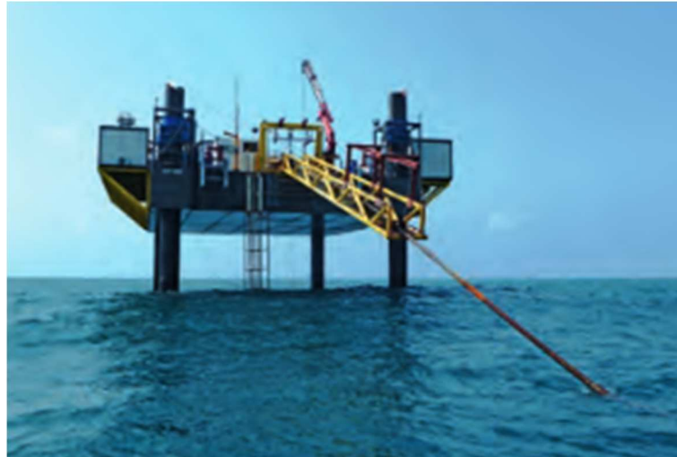
Figura 3.5.51: Tipica chiatta per l'installazione offshore della postazione di spinta
