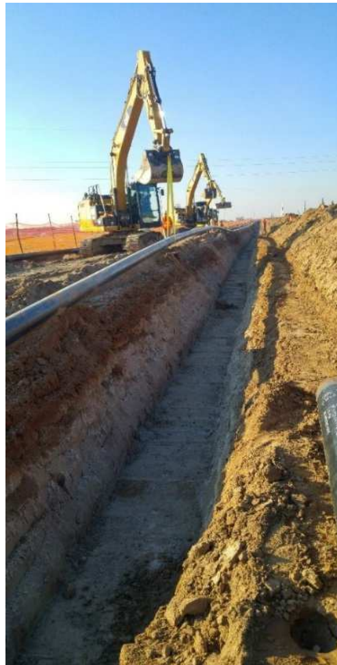
Figura 3.5.14: Esempio di posa con escavatori
