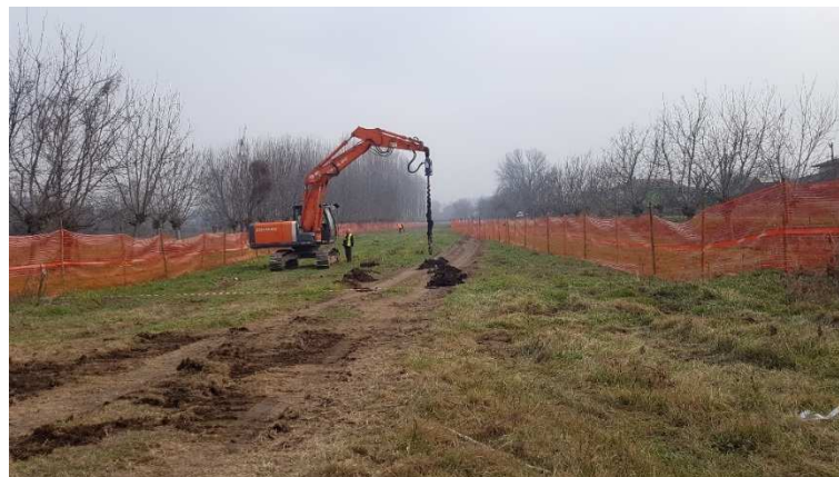
Figura 3.5.1: Esempio di bonifica bellica lungo la ROW
