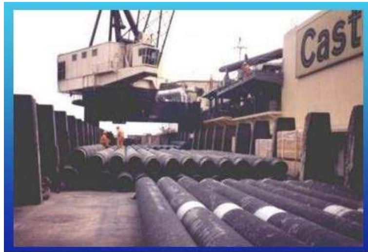
Figura 3.5.28: Posa tubi "S-lay" - Tipica area di accatastamento a bordo dei tubi
