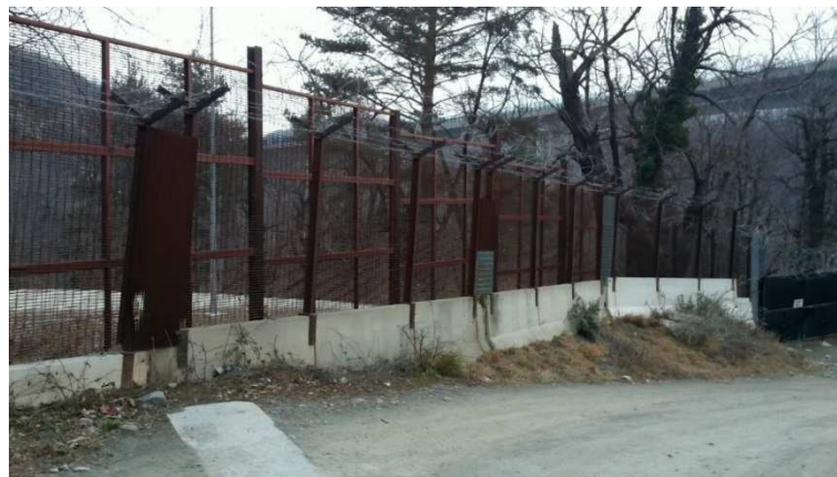
Figura 3.5.7: Esempio di recinzione per l'area lavoro
