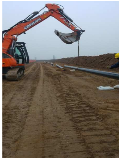
Figura 3.5.8: Esempio di sfilamento dei tubi
