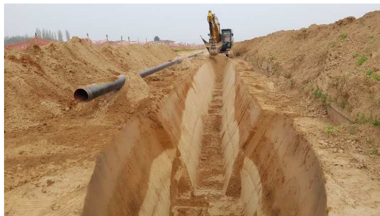
Figura 3.5.10: Esempio di scavo di una trincea con terreni sciolti
