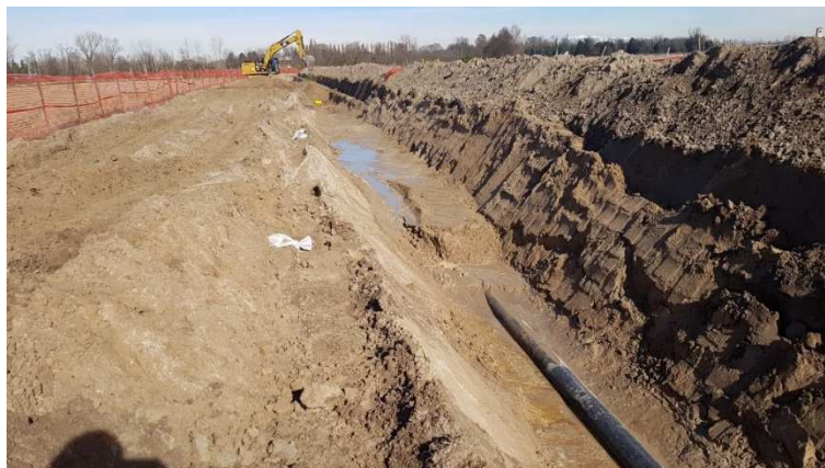
Figura 3.5.17: Reinterro della condotta
