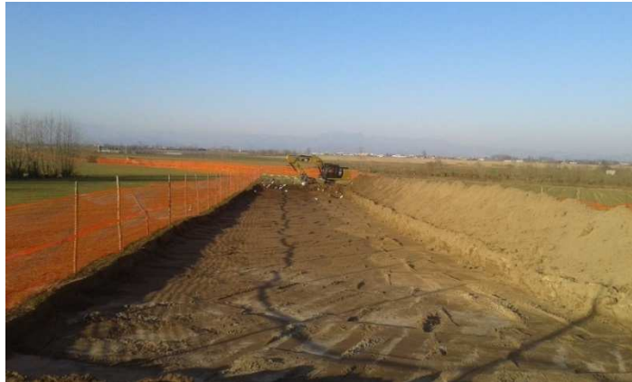
Figura 3.5.4: Esempio di pista di lavoro
