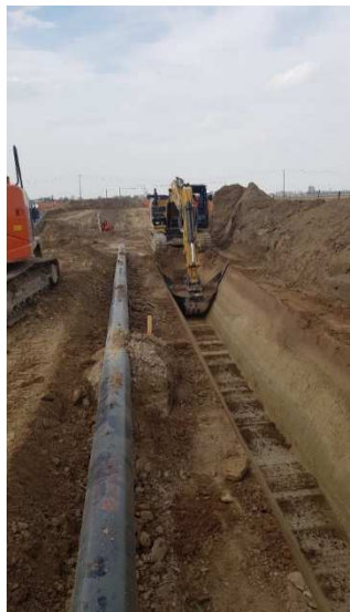
Figura 3.5.12: Scavo della trincea con escavatore
