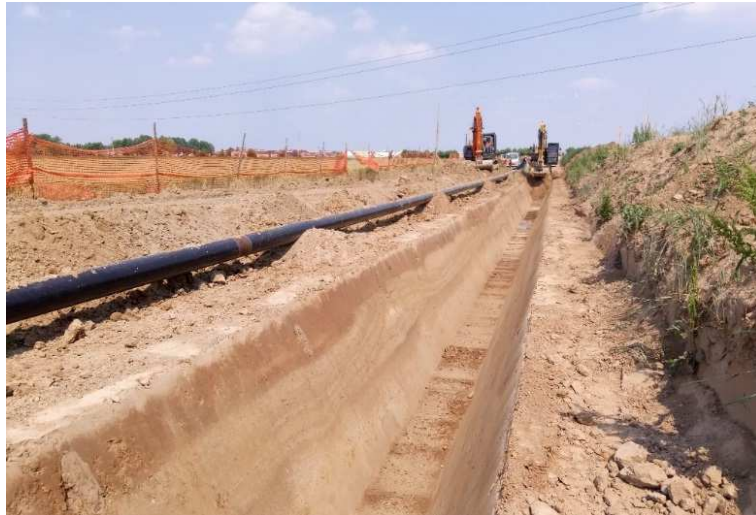
Figura 3.5.11: Scavo della trincea con tubazioni saldate lungo la pista lavoro
