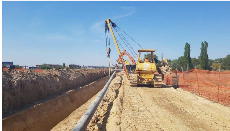
Figura 3.5.15: Posa con "sideboom"
