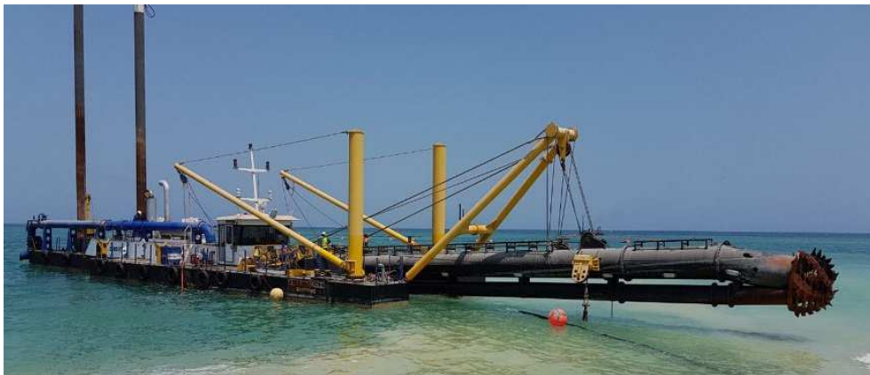
Figura 3.5.21: Lavori di preparazione all'uscita a mare della TOC
