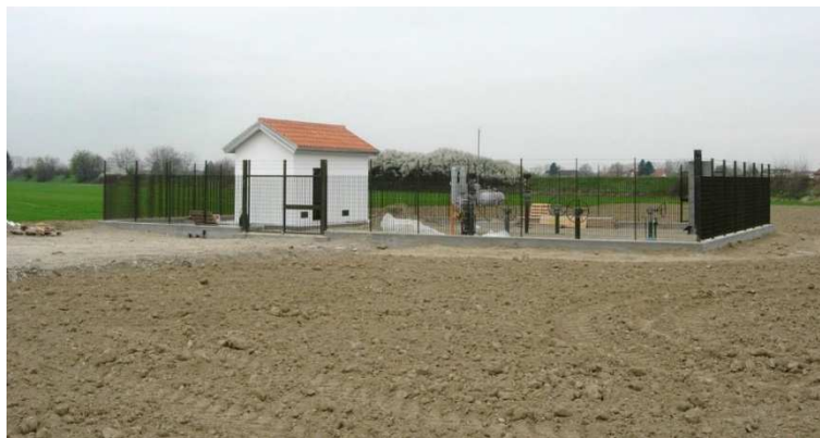
Figura 3.5.44: Esempio di punto di intercettazione di linea
