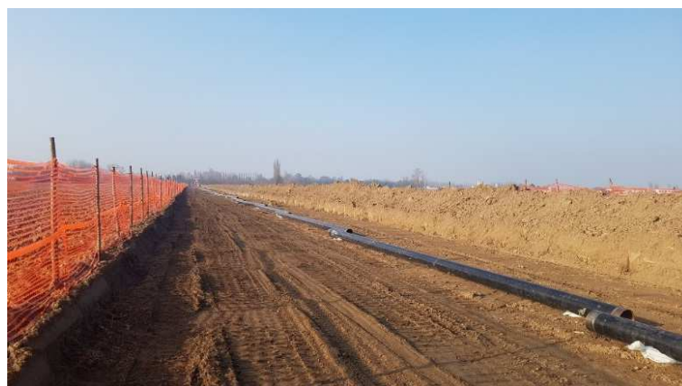
Figura 3.5.9: Sfilamento dei tubi lungo la pista di lavoro
