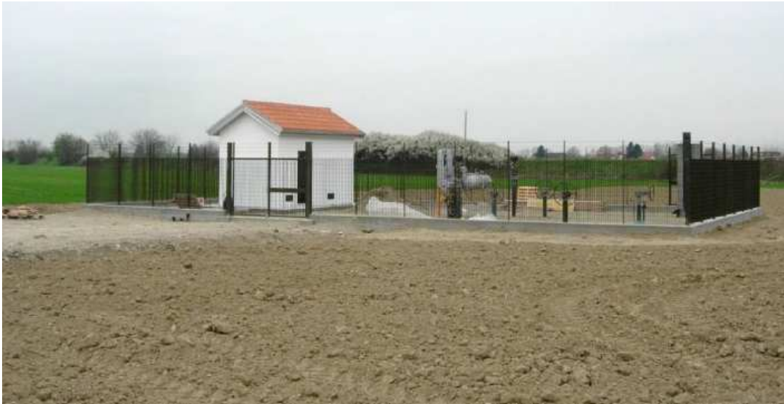
Figura 5.3.12: Esempio di una stazione "Block Valve"
