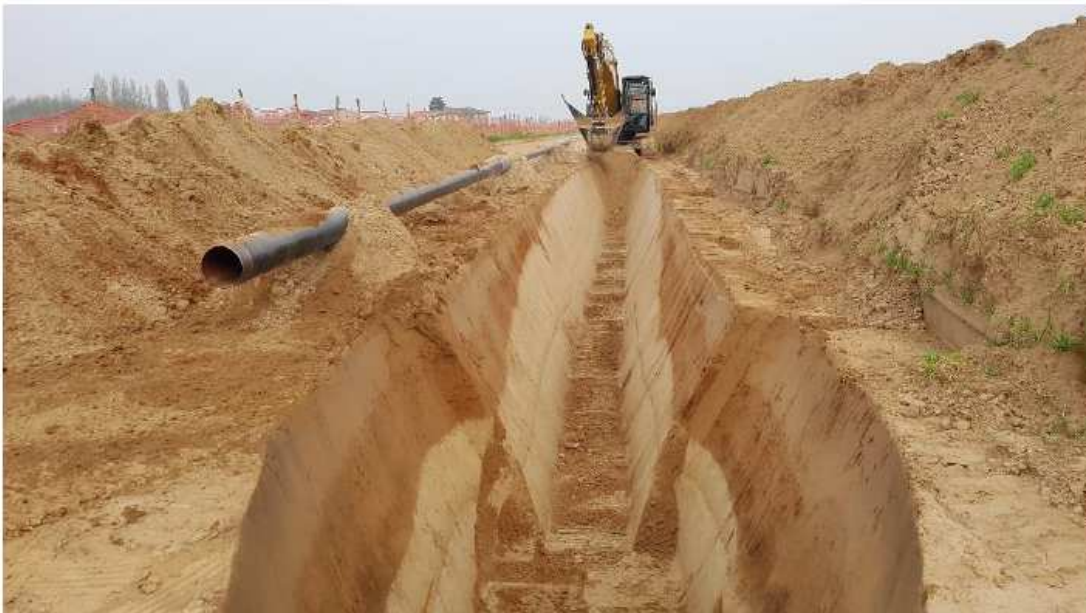
Figura 5.3.10: Esempio di scavo della trincea
