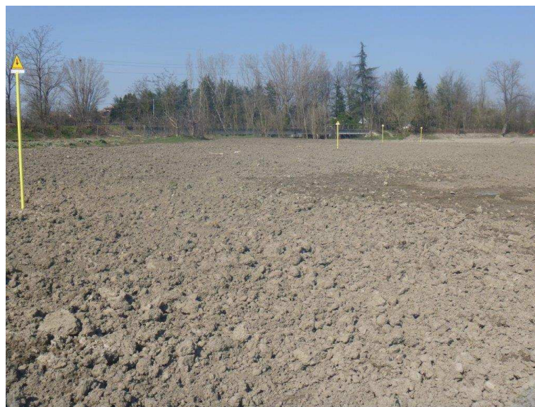
Figura 6.1.1: Pista di lavoro su terreni agricoli dopo i ripristini
