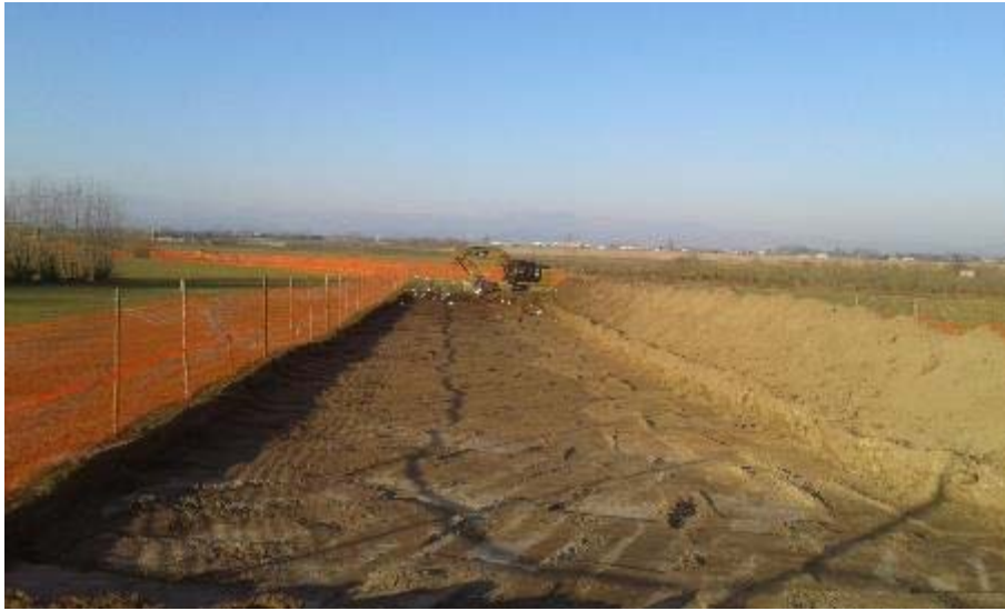
Figura 2-2– Esempio di pista di lavoro
