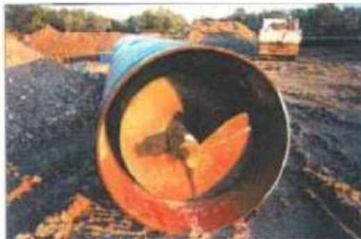
Figura 2-5 – Coclea di una spingitubo
