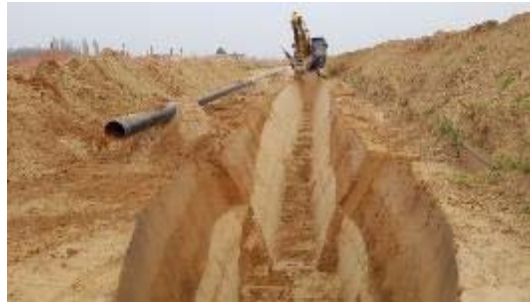
Figura 2-3 – Esempio di scavo di una trincea con terreni sciolti
