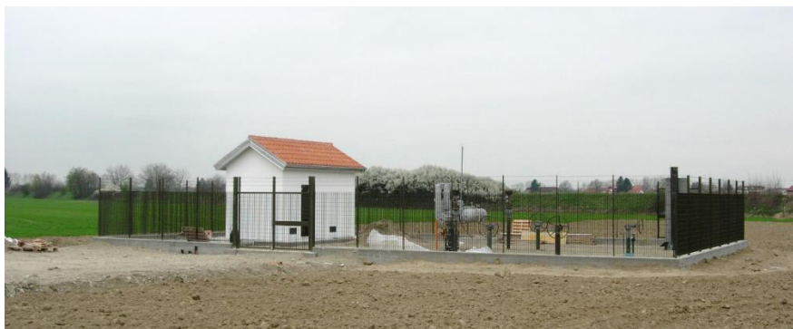
Figura 8. Esempio di impianto per intercettazione linea
