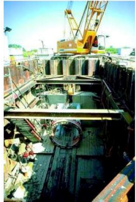
Figura 7 Esempio delle installazioni di spinta per i tunnel: in progetto sono previste due stazioni lungo le pendici est di Farello ed ovest del vallone Priolo
