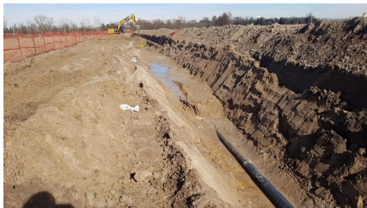
Figura 2.4.17: Reinterro della condotta
