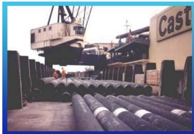
Figura 2.4.28: Posa tubi "S-lay" - Tipica area di accatastamento a bordo dei tubi
