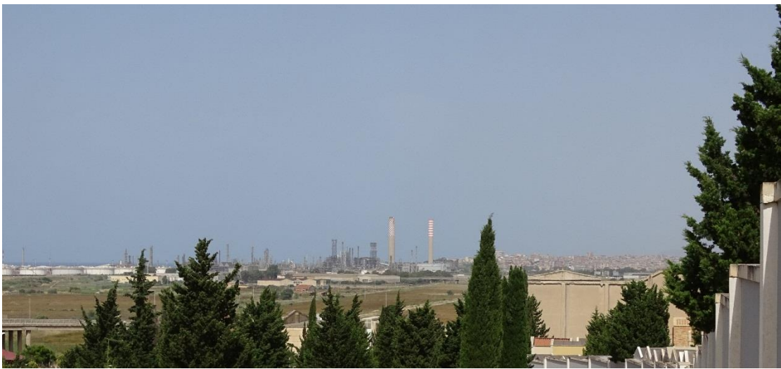
Figura 4.6.2: Vista panoramica sul sito petrolchimico (nello sfondo)
