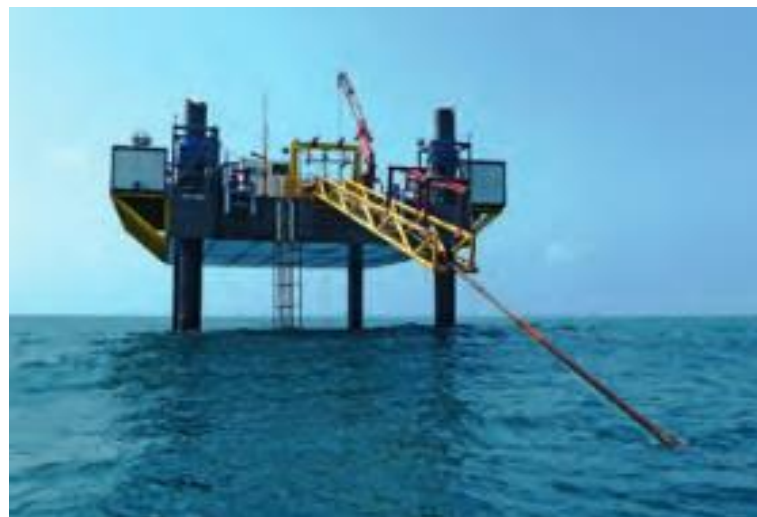
Figura 2.4.50: Tipica chiatta per l'installazione offshore della postazione di spinta
