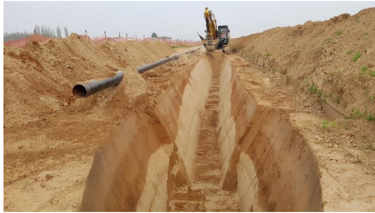
Figura 2.4.10: Esempio di scavo di una trincea con terreni sciolti
