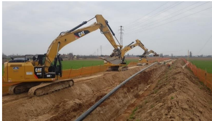
Figura 2.4.16: Posa della colonna
