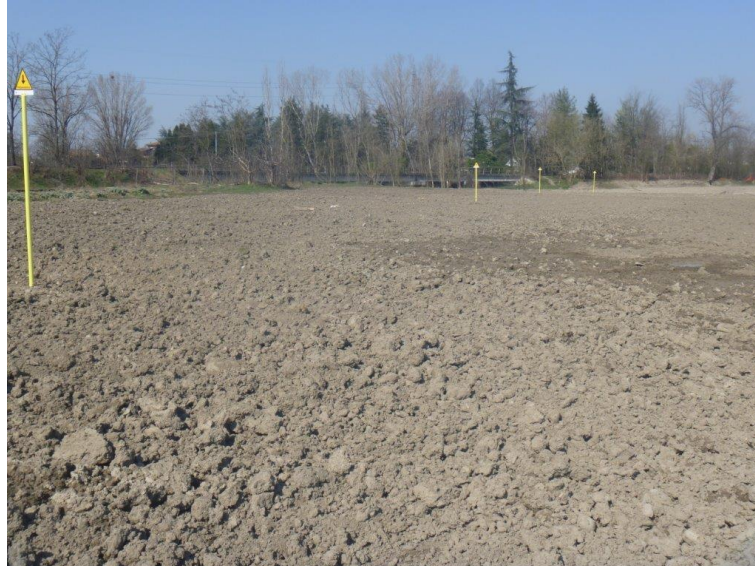
Figura 2.5.1: Pista di lavoro su terreni agricoli dopo i ripristini
