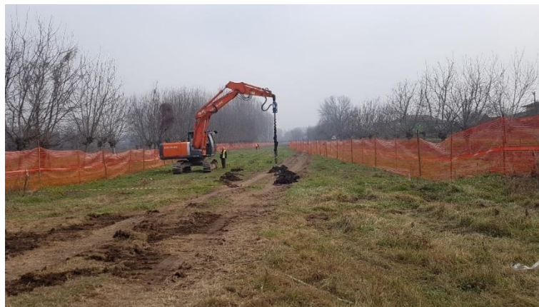
Figura 2.4.1: Esempio di bonifica bellica lungo la ROW
