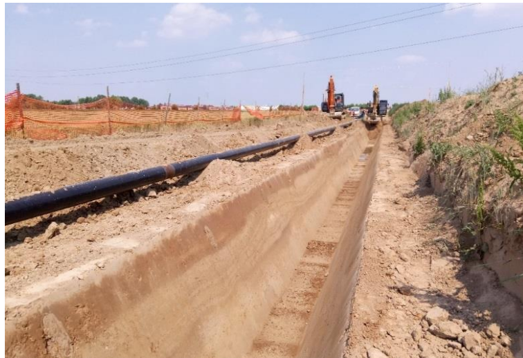
Figura 2.4.11: Scavo della trincea con tubazioni saldate lungo la pista lavoro
