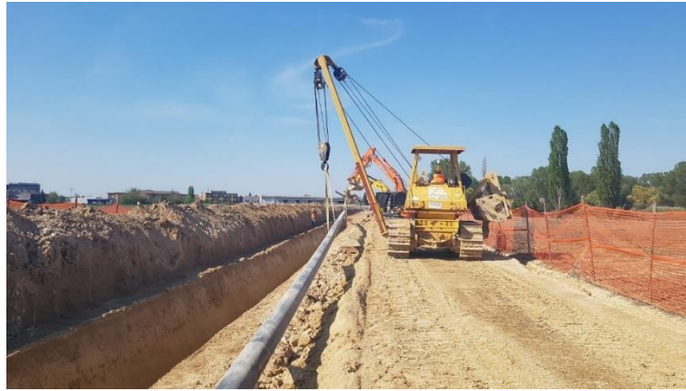
Figura 2.4.15: Posa con "sideboom"
