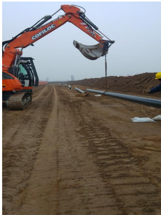
Figura 2.4.8: Esempio di sfilamento dei tubi
