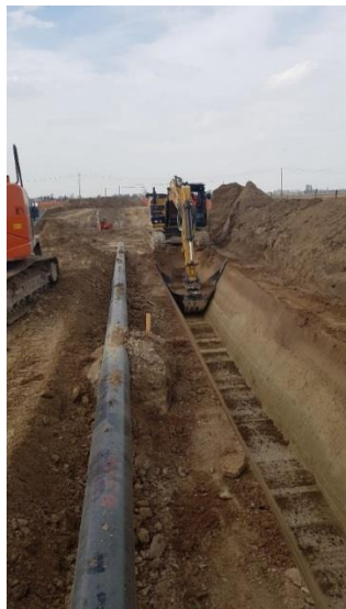
Figura 2.4.12: Scavo della trincea con escavatore
