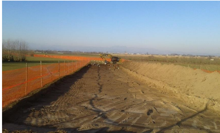
Figura 2.4.4: Esempio di pista di lavoro
