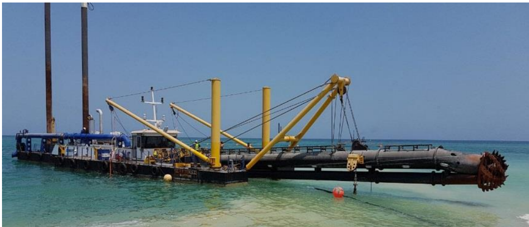
Figura 2.4.21: Lavori di preparazione all'uscita a mare della TOC
