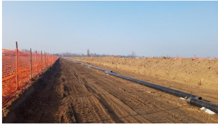
Figura 2.4.9: Sfilamento dei tubi lungo la pista di lavoro
