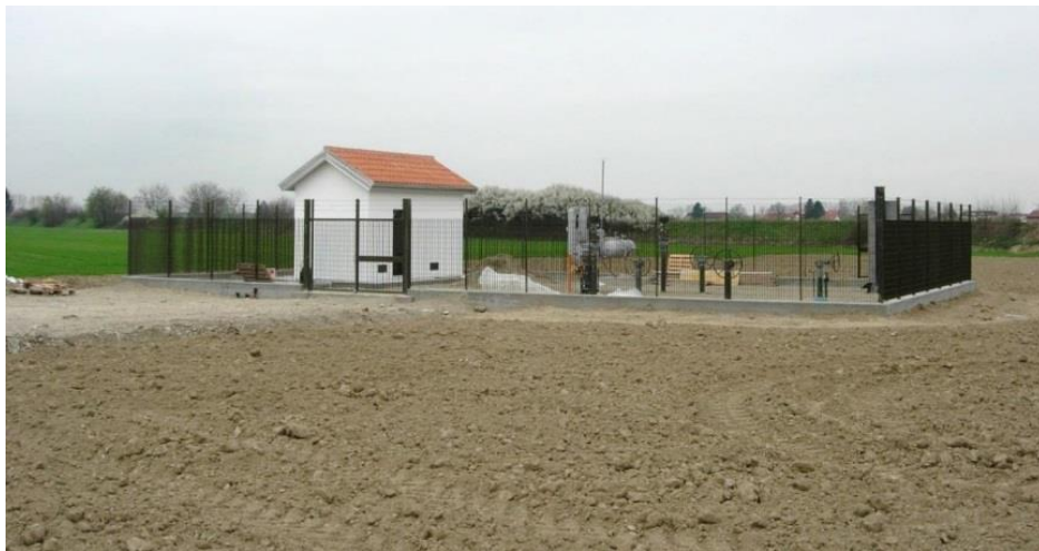
Figura 2.4.44: Esempio di punto di intercettazione di linea
