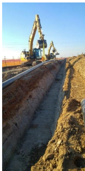
Figura 2.4.14: Esempio di posa con escavatori
