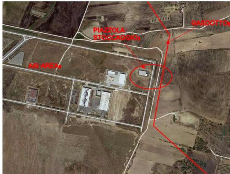
Figura 2.4.2: Area temporanea di stoccaggio/lavoro a Gela
