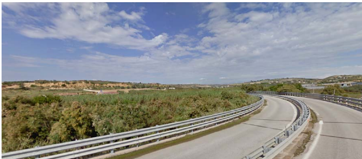
Figura 6-7 Veduta ambito ripariale del F. Priolo nei pressi dell'attraversamento con l'E45
