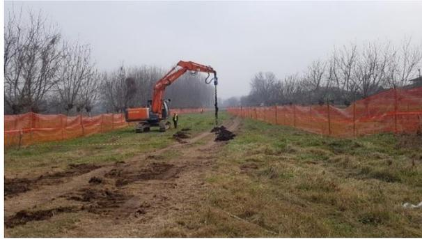
*Figura 3: Esempio di bonifica bellica*
