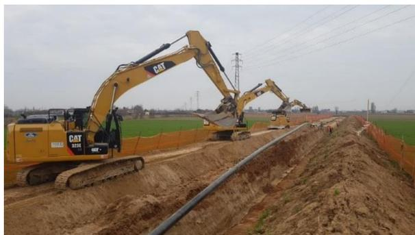
*Figura 6: Esempio di posa del gasdotto*
