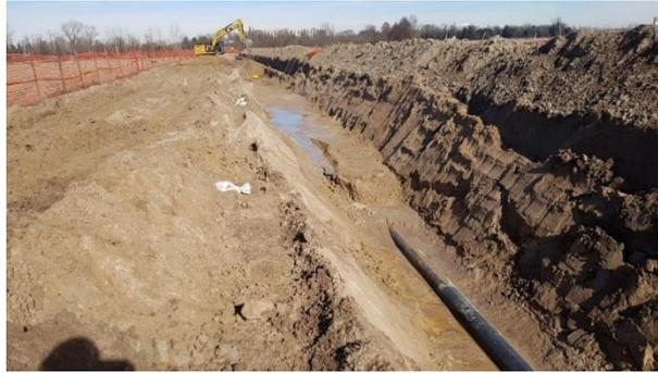
Figura 7: Esempio di reinterro della condotta
