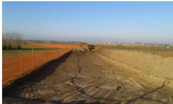
*Figura 5: Esempio di pista di lavoro*
