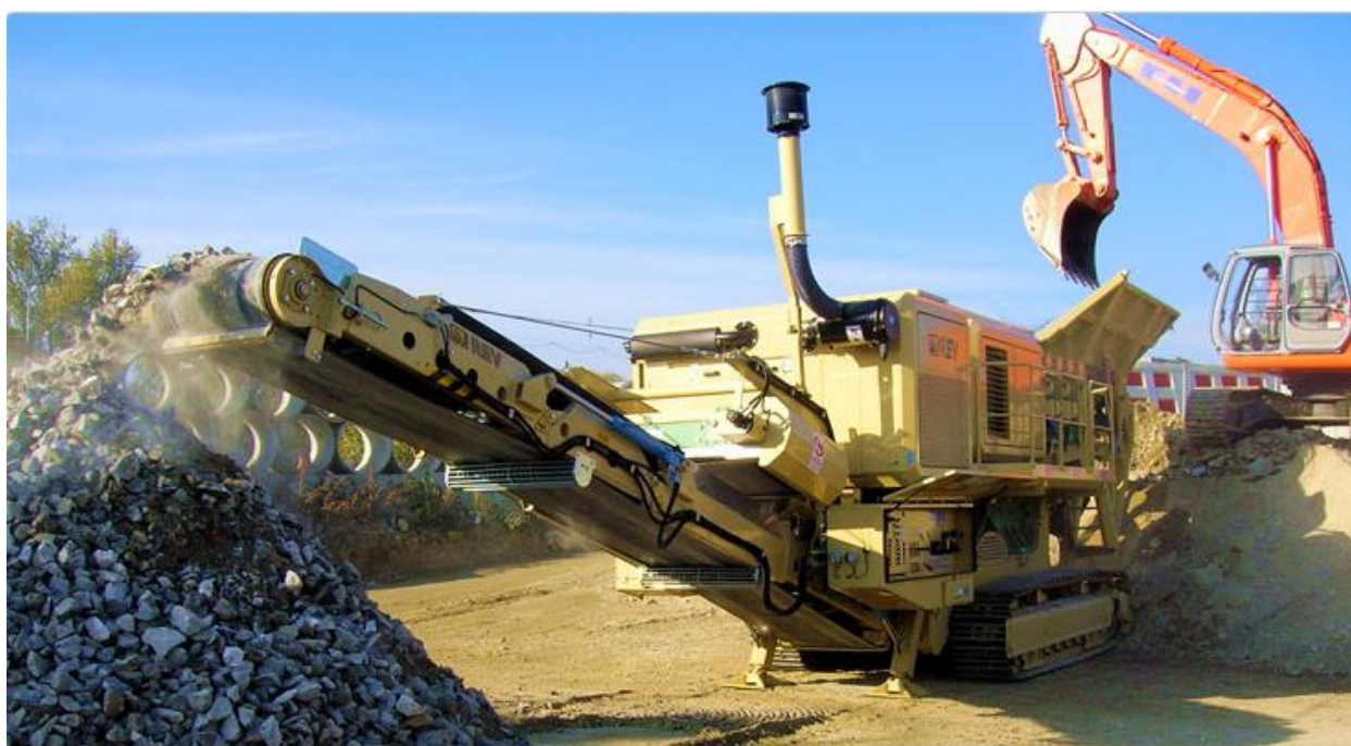
Figura 5.12 – Tipico frantoio mobile per il riutilizzo in sito delle rocce da scavo
