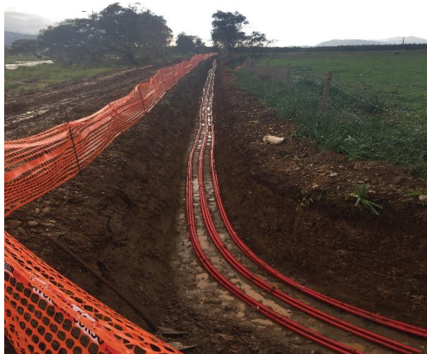
Figura 9.1 - Posa cavidotti MT parco del Guspinese
