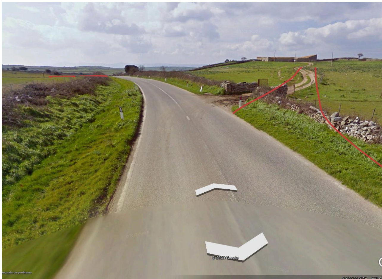
Figura 8.1 - Indicazione schematica della sistemazione dell'accesso alla viabilità di collegamento alla postazione BAP1 presso la SP 40
