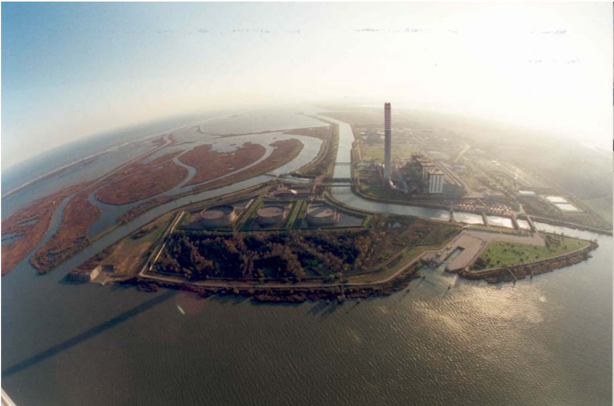
Foto n.1 – Vista aerea dell'impianto – situazione attuale
