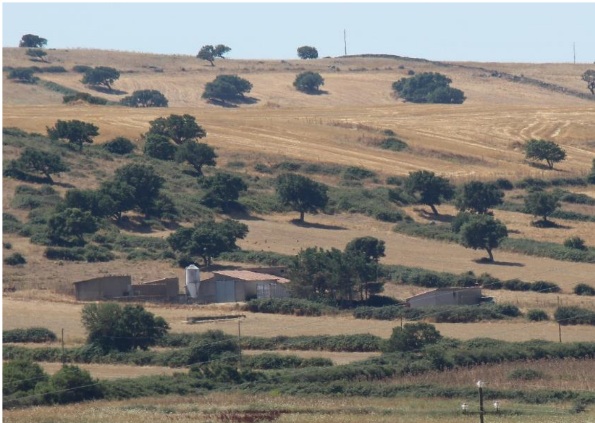
Figura 4.9 – Edificio F37 (vista da nordest)
