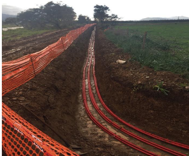
Figura 6.5 - Posa cavidotti MT parco del Guspinese
