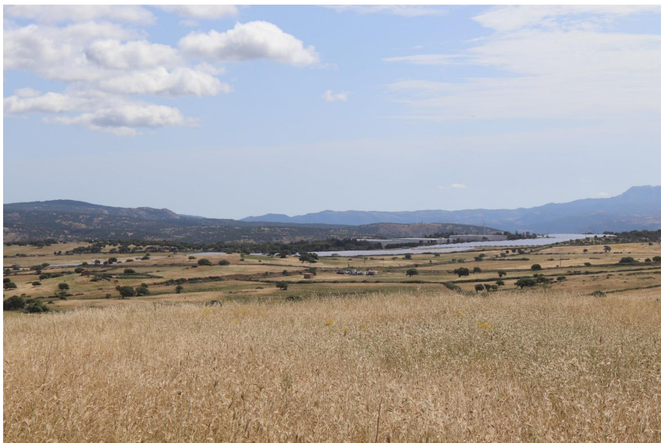
Figura 6.9 – Veduta del campo fotovoltaico ubicato all'interno dell'area PIP di Bitti
