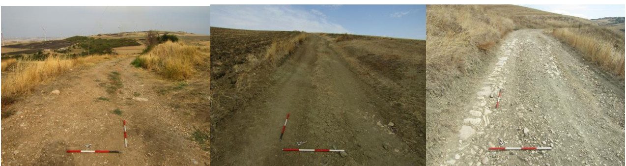
Viabilità e cavidotto interno su strada vicinale e comunale WTG 10-11-12.
