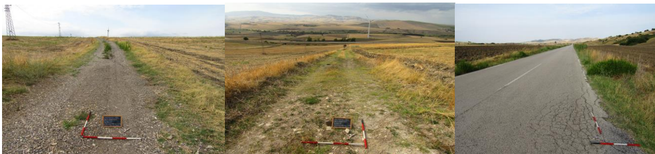
Viabilità e cavidotto esterno su strada comunale e provinciale.
