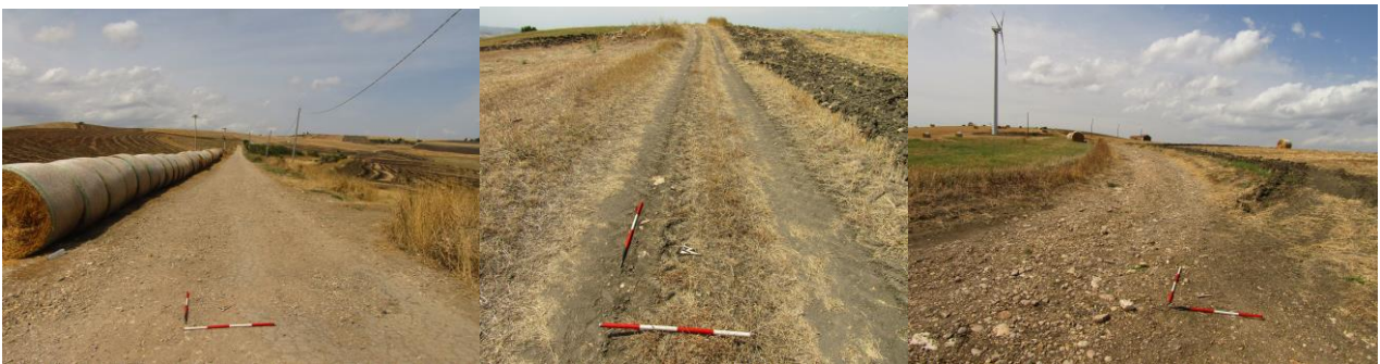
Viabilità e cavidotto interno su strada vicinale e privata nel tratto WTG 05-08.
