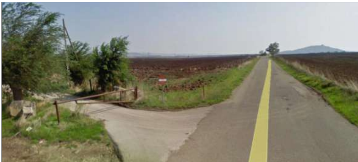
Foto 1: punto d'inizio del tracciato – ingresso cabina primaria
