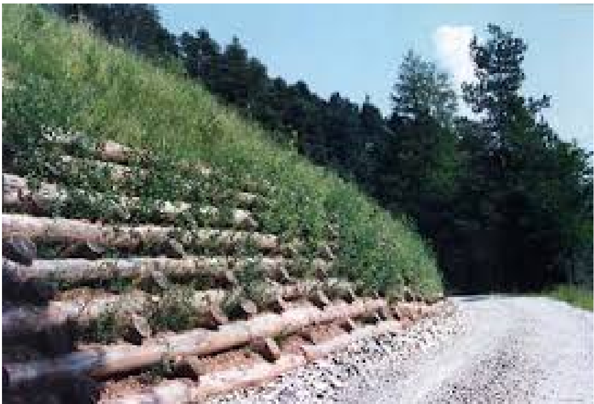
Figura 11: esempio di palizzata di legname di talee autoctone rinforzata con biostuoia rinverditata (mediante idrosemina)
