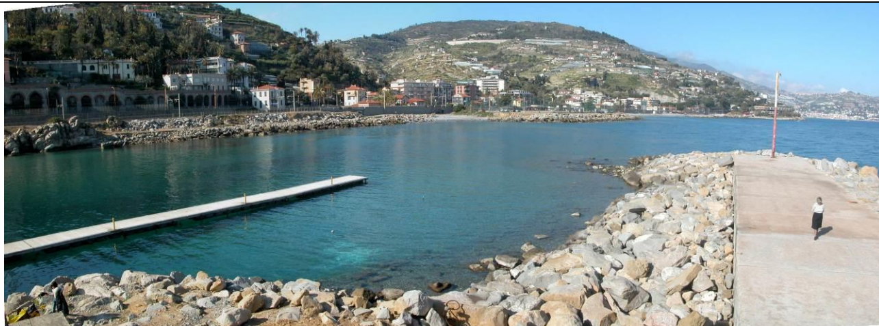
FIGURA N°7: Foto fondale del litorale tra capo S.Ampelio al porto attuale
