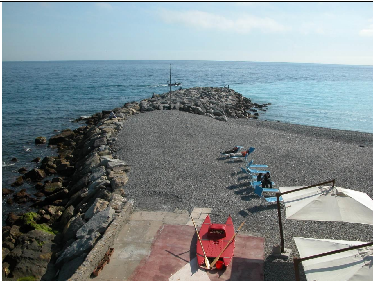
FIGURA N°5: Foto fondale a ponente ed a levante di capo S. Ampelio
