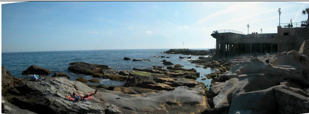
FIGURA N°2: Foto litorale verso capo S.Ampelio
