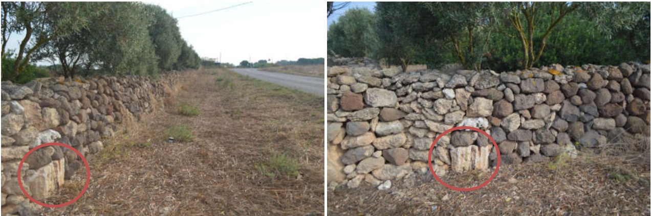
Figura 31. Strada provinciale 6, lato occidentale (da sud) e particolare struttura di recinzione che reimpiega un tratto di opus mixtum .
