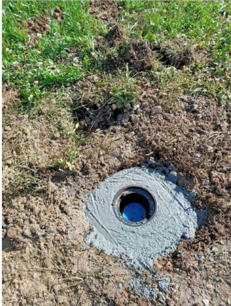
*Figura 9 – Tubo piezometrico installato nel foro di sondaggio S1*
