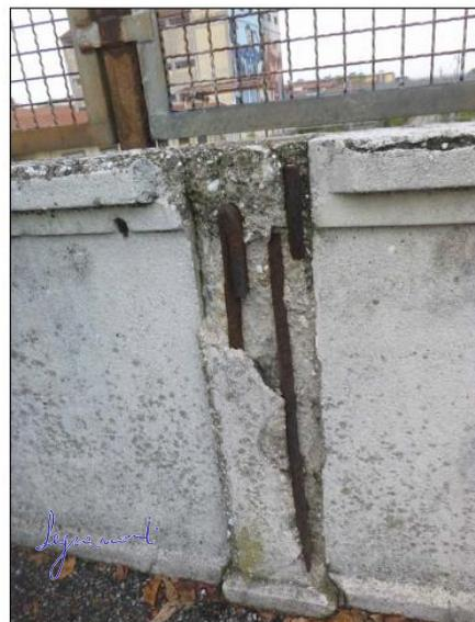
Foto 5 Vista generale e di dettaglio del parapetto con presenza di ruggine ed espulsione del copriferro
