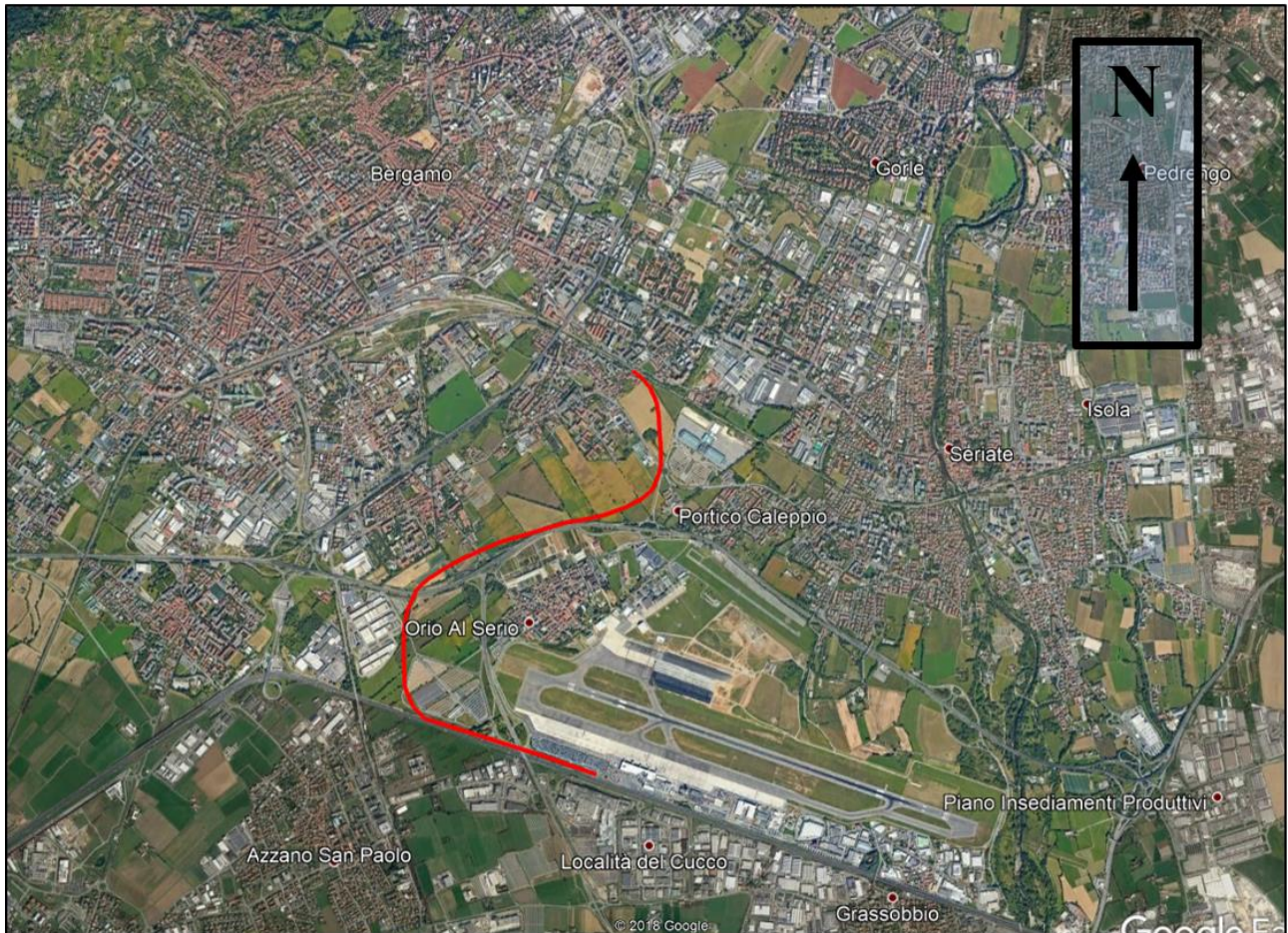
Figura 3-3 - Immagine aerea dell'area tra la città di Bergamo e l'aeroporto di Orio al Serio, in rosso si evidenzia il tracciato oggetto di studio. (Immagine da Google Earth).
