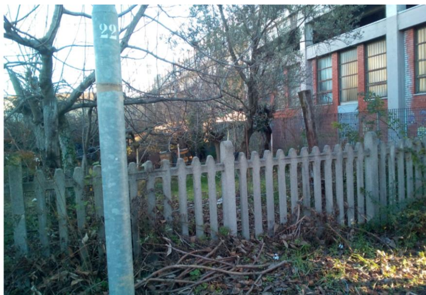
Foto 2 – Vista dell'area di cantiere AT.07 (fonte sopralluogo)
