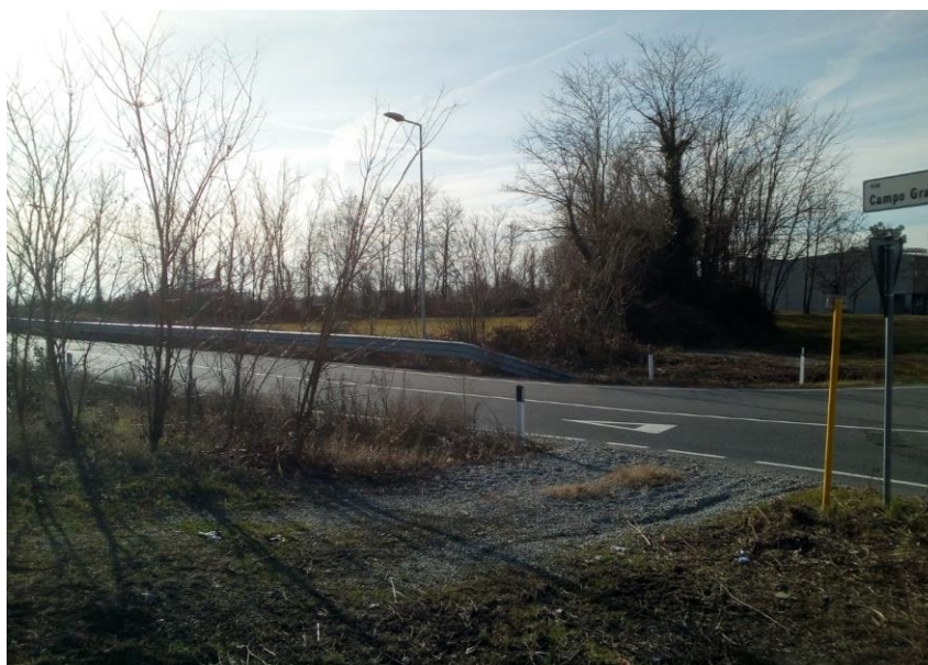
Vista 1 (da via Campo Grande) del sedime interessato dall'opera e della partenza della pista di cantiere (fonte sopralluogo)
