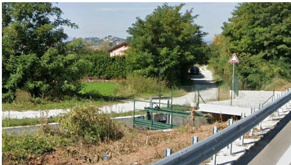
Vista della viabilità sterrata – via dei Prati
