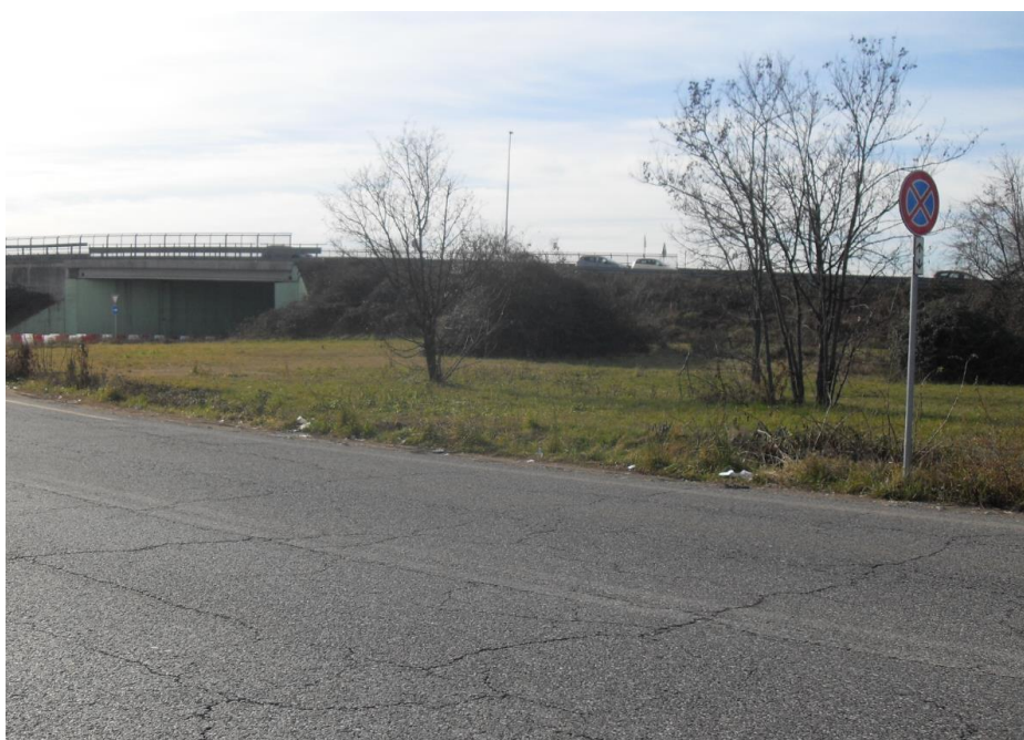
Foto2 - Vista del cantiere CO.04 dalla rampa di immissione sulla SP – dir. Nord (fonte sopralluogo)
