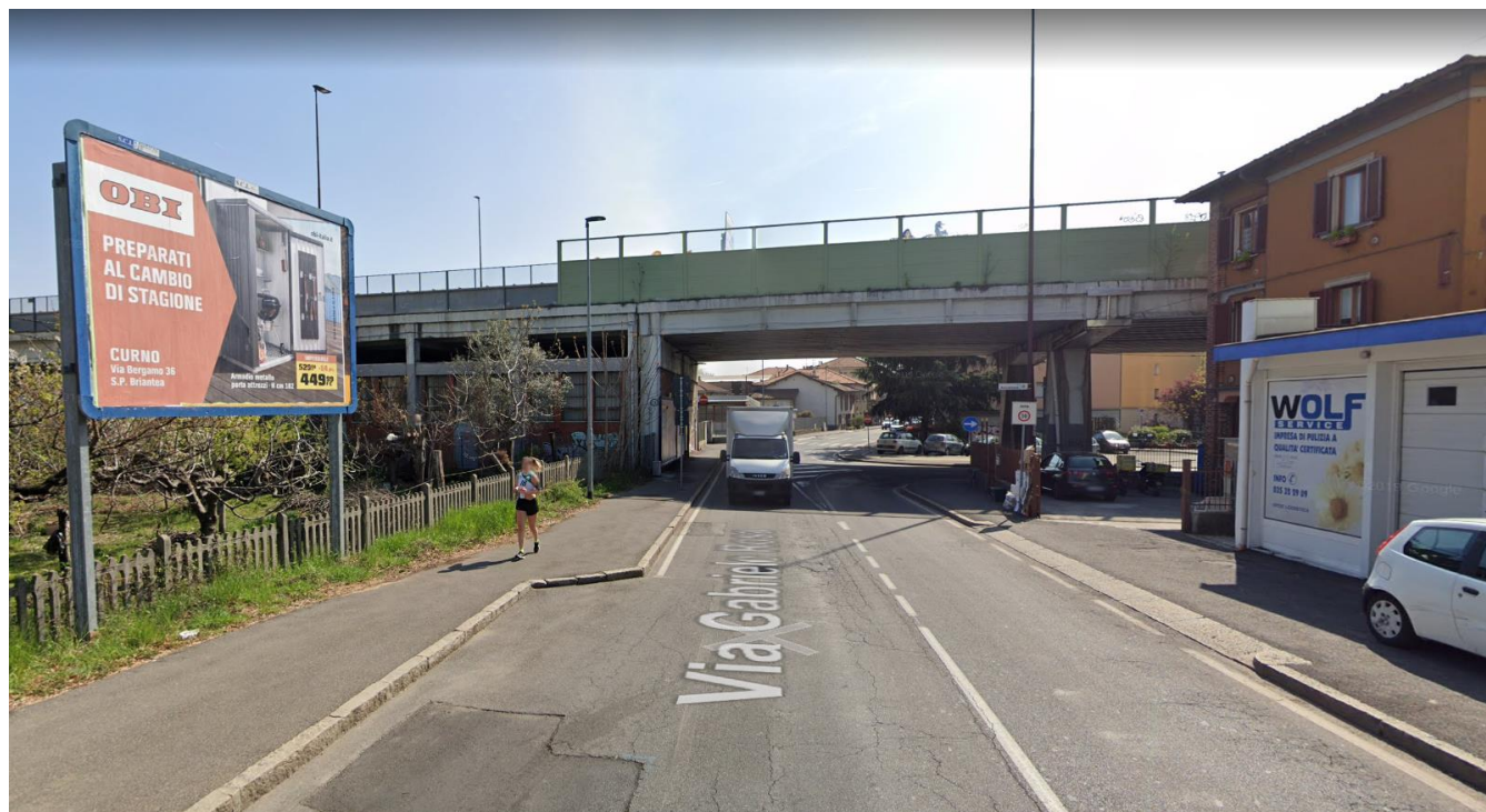
Vista direzione est - della viabilità di accesso al cantiere (fonte sopralluogo)
