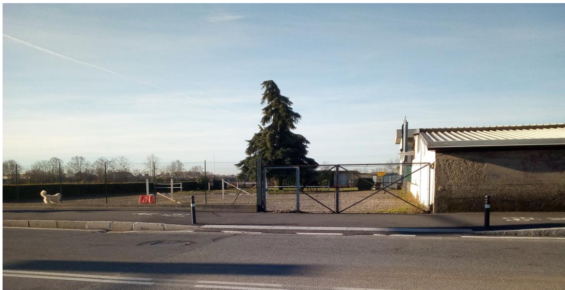
Foto 1 – vista dell'area di cantiere AT.01 da Via Lunga (fonte sopralluogo)
