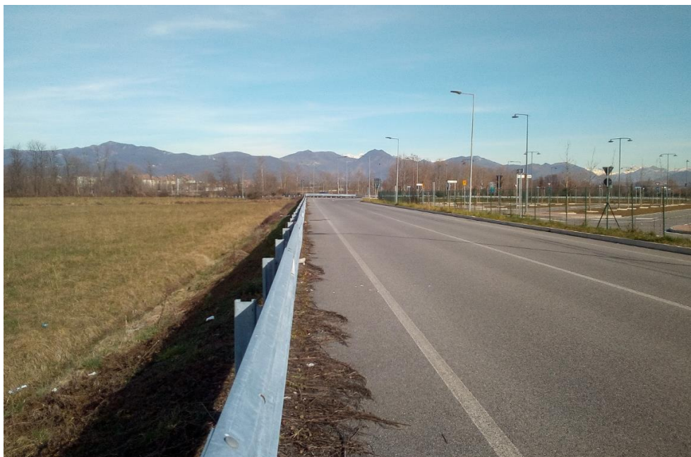
Vista della viabilità di accesso (fonte sopralluogo)
