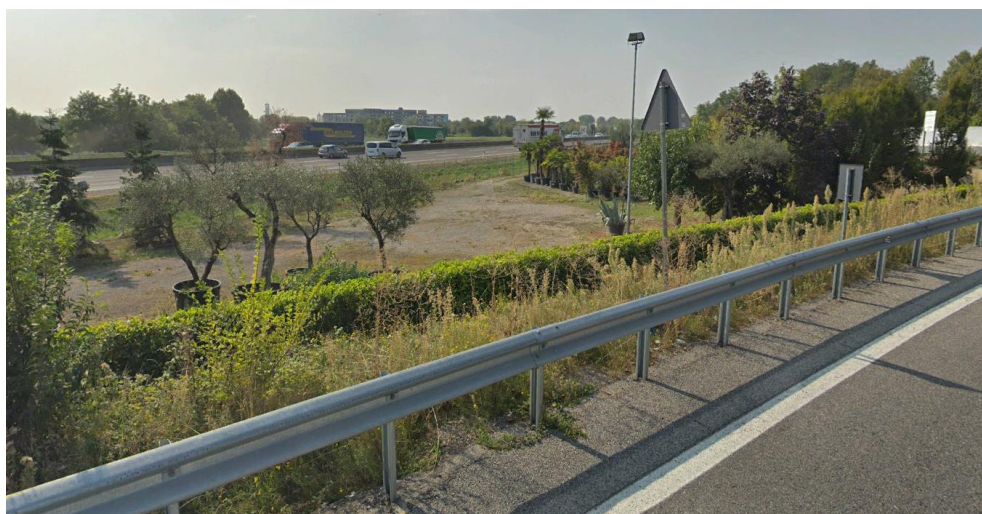
Foto 2 – Vista dell'area di cantiere CO.03 dalla rampa per l'accesso alla SP ex SS591 Bis dir. sud (fonte Google Street View)
