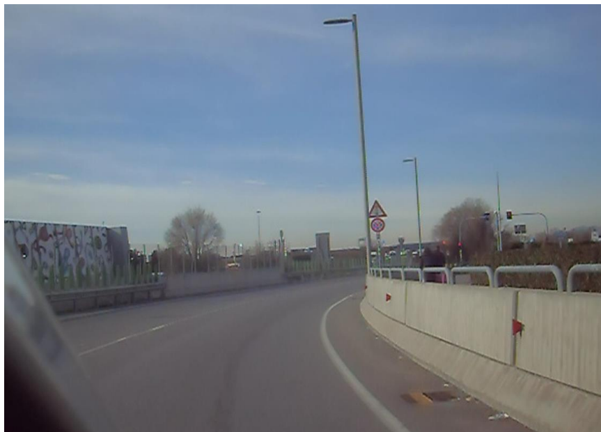
Foto1 - Vista del cantiere CO.05 dalla SP116 (fonte sopralluogo)
