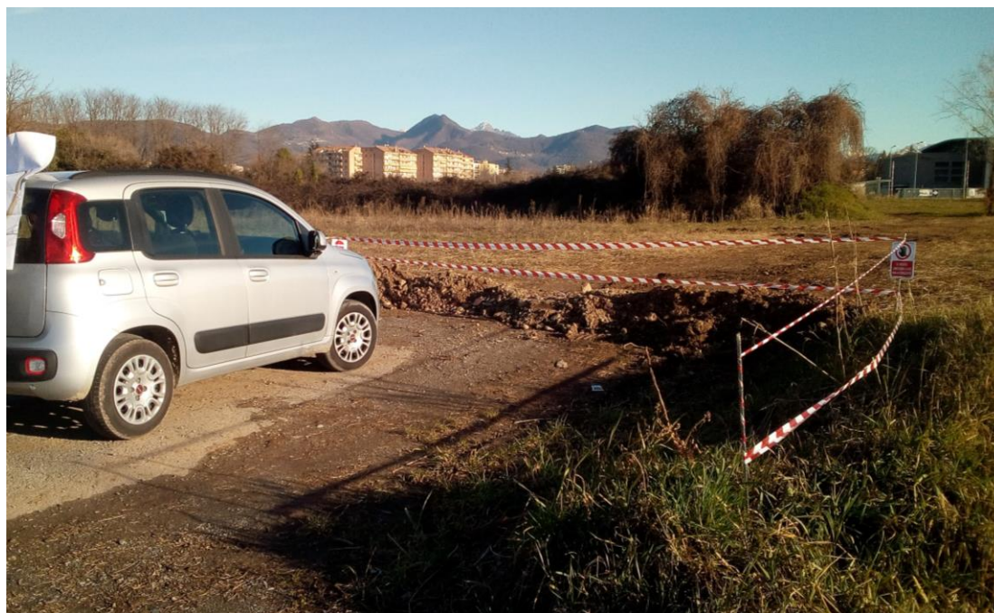
Foto 2 – vista dell'area di cantiere AT.02 (fonte sopralluogo)
