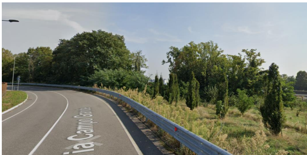
Vista della viabilità di accesso al cantiere da via Campogrande
