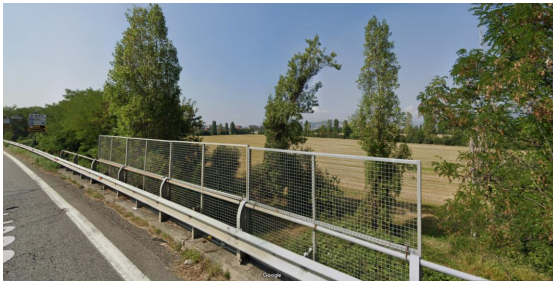
Foto 1 - Vista del cantiere CO.01 dalla SS671 (fonte google street view)
