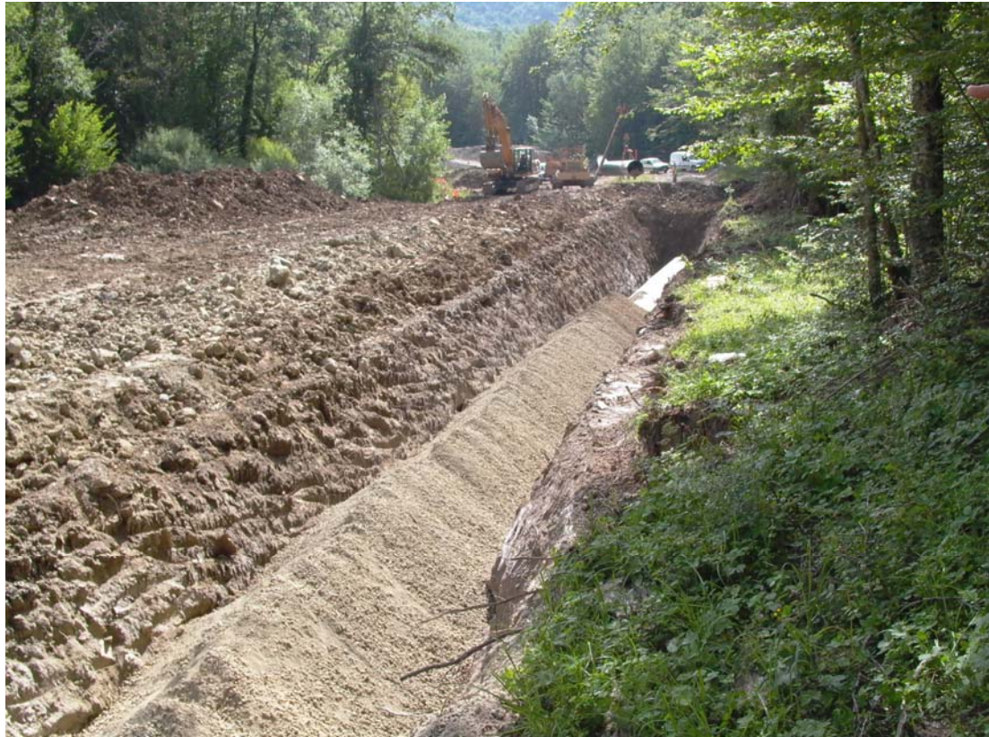
Foto II 5.1.9.A - Rinterro della condotta
