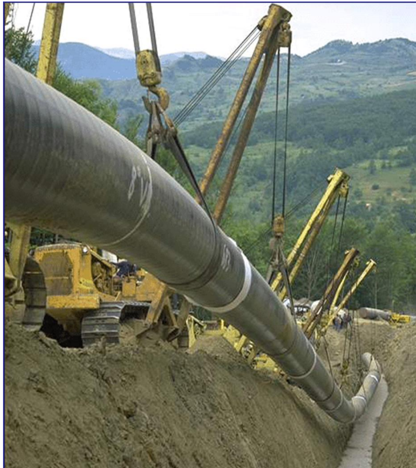
Foto II 5.1.8.A - Posa della condotta
