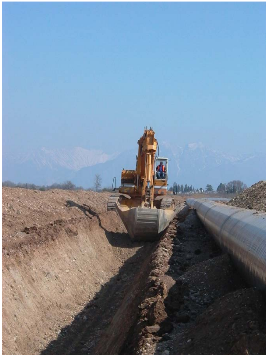
Foto II 5.1.6.A - Scavo della trincea
