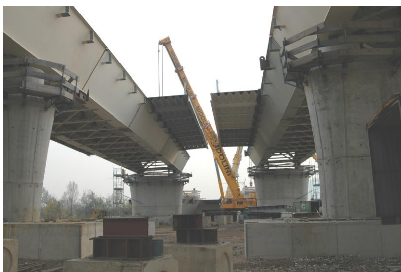
F1. Varo dal basso di viadotto in acciaio
