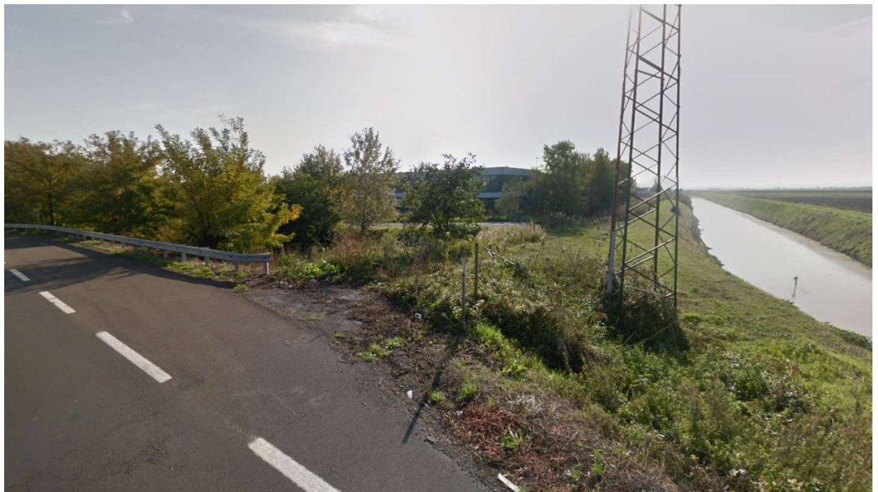
Figura 21: accesso km 148+800 dir. Sud
