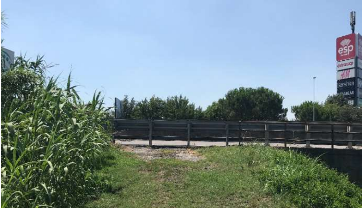
Figura 26: accesso km 151+640 dir. Nord
