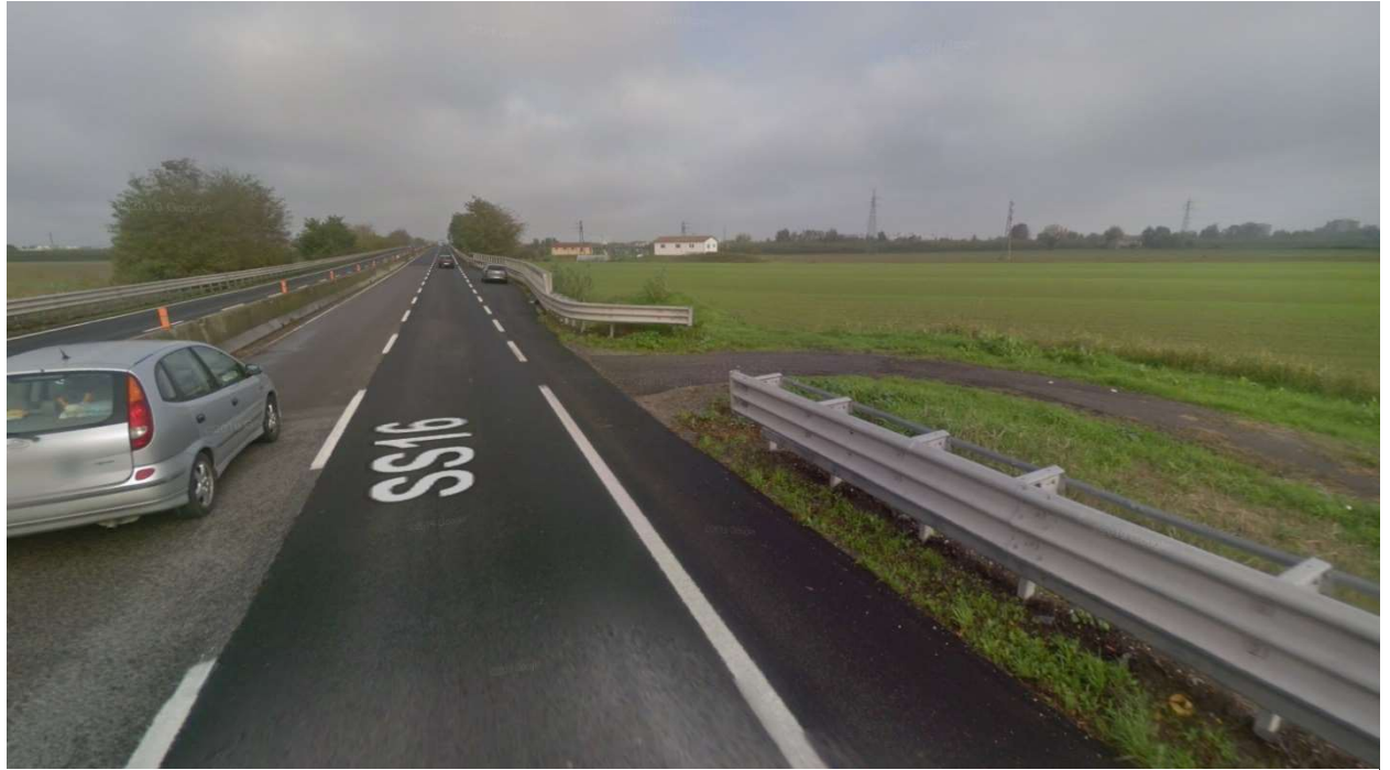
Figura 28: accesso km 152+470 dir. Sud
