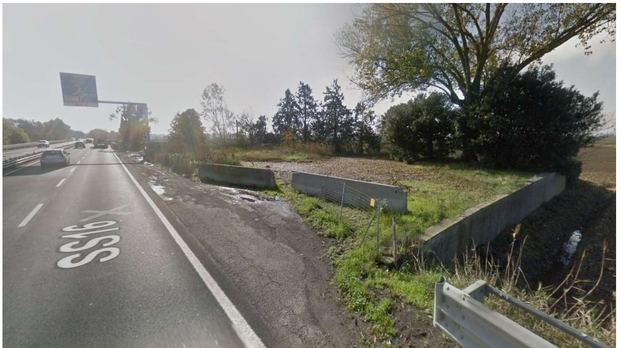
Figura 29: accesso km 152+575 dir. Sud
