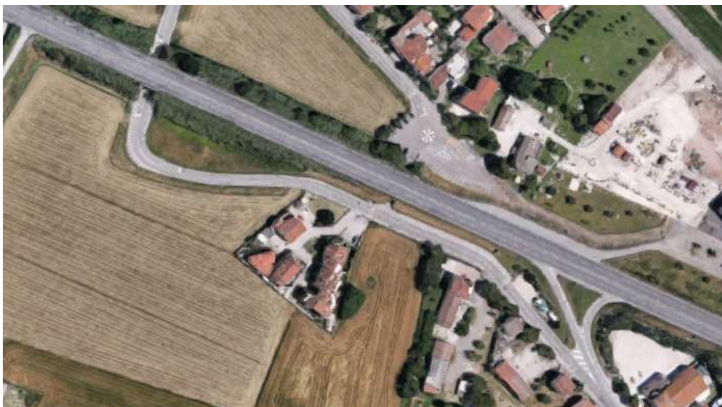
Figura 31: Viabilità secondaria da km 153+600 a km 153+700
