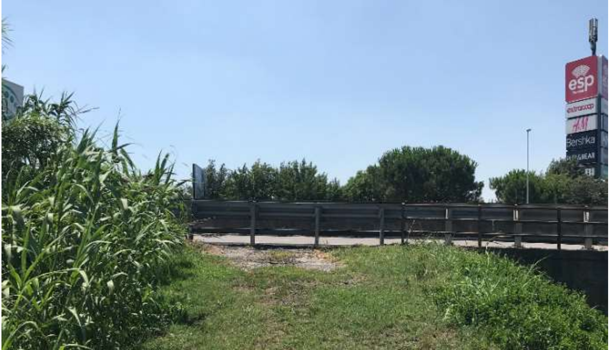
Figura 10: accesso km 151+640 dir. Nord
