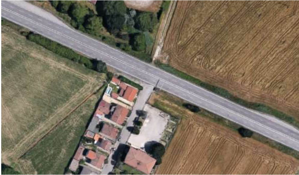
Figura 32: Viabilità secondaria km 154+070
