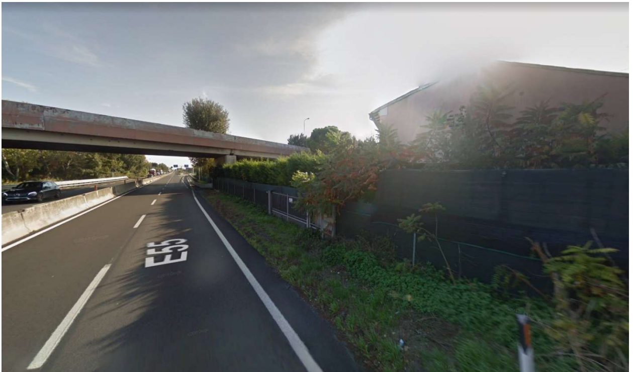
Figura 9: accesso km 151+160 dir. Sud
