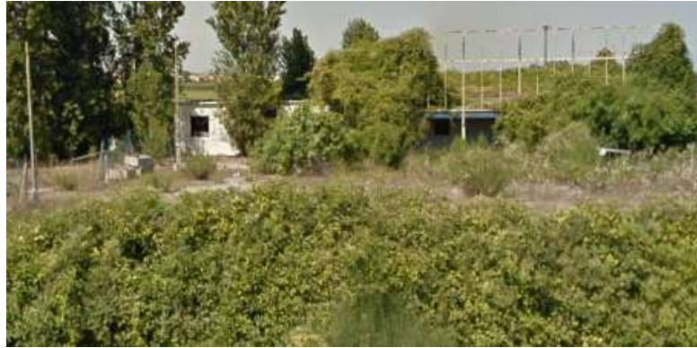
Figura 7: Edificio da espropriare al km 154+350
