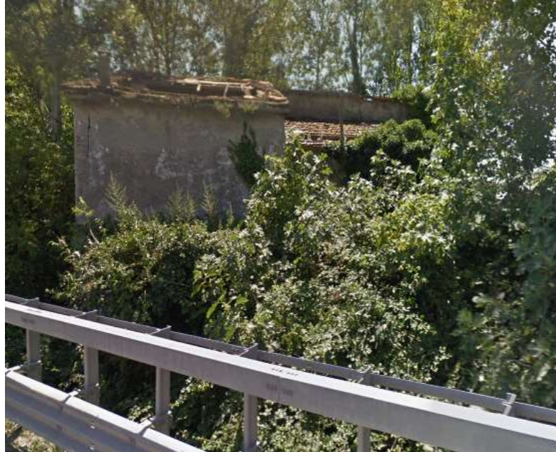
Figura 5: Edificio da espropriare al km 150+200
