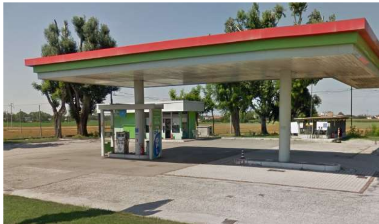
Figura 6: Edificio da espropriare al km 154+250
