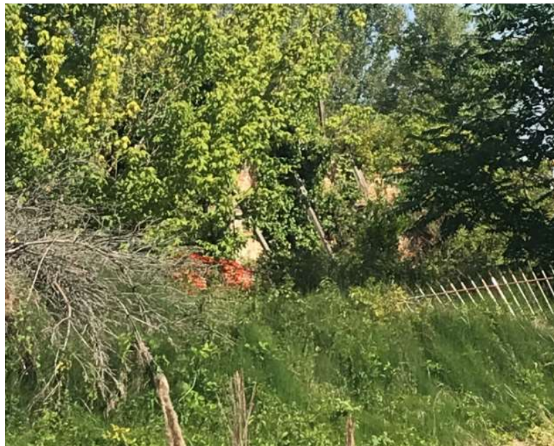
Figura 4: Edificio da espropriare al km 149+400
