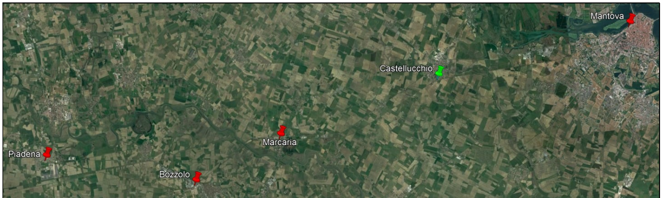
Figura 2 - Stato attuale area oggetto di intervento
