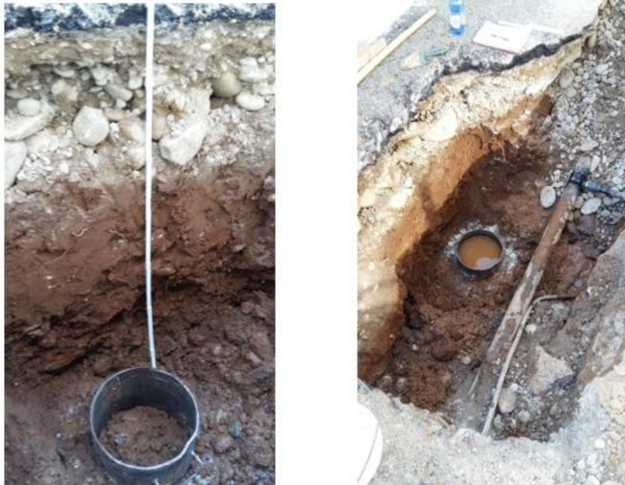
Figura 5 - Fasi di esecuzione delle prove di permeabilità.
