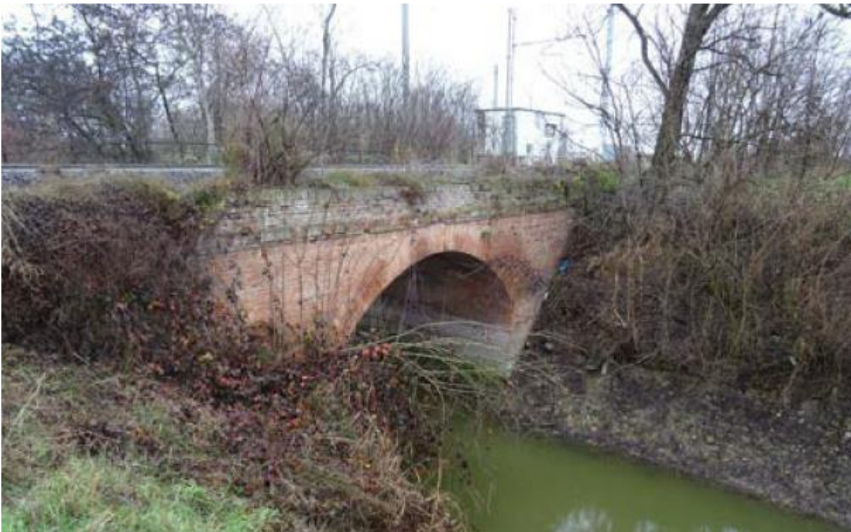
Figura 3 - Foto VI03 sopralluogo
