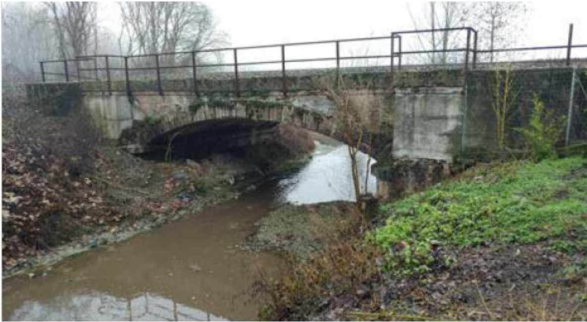
Figura 9 - Foto opera IN24 sopralluogo
