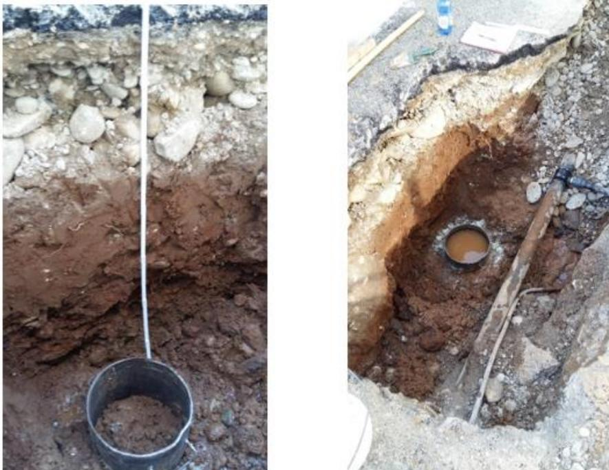
**Figura 3 - Fasi di esecuzione delle prove di permeabilità.**
