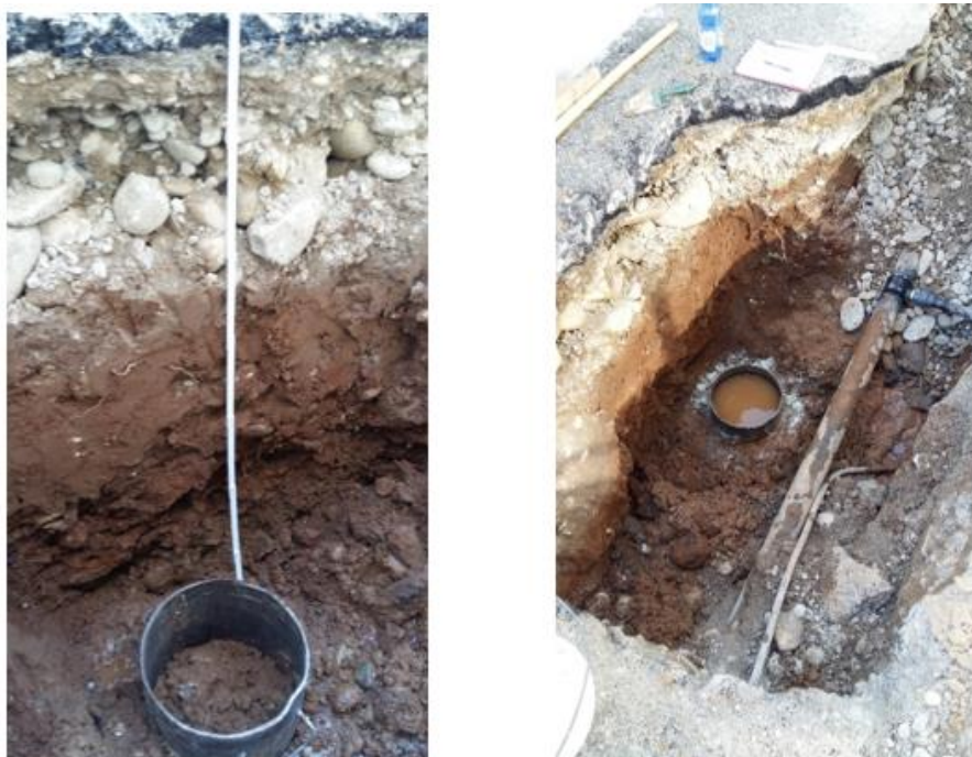
Figura 3 - Fasi di esecuzione delle prove di permeabilità.
