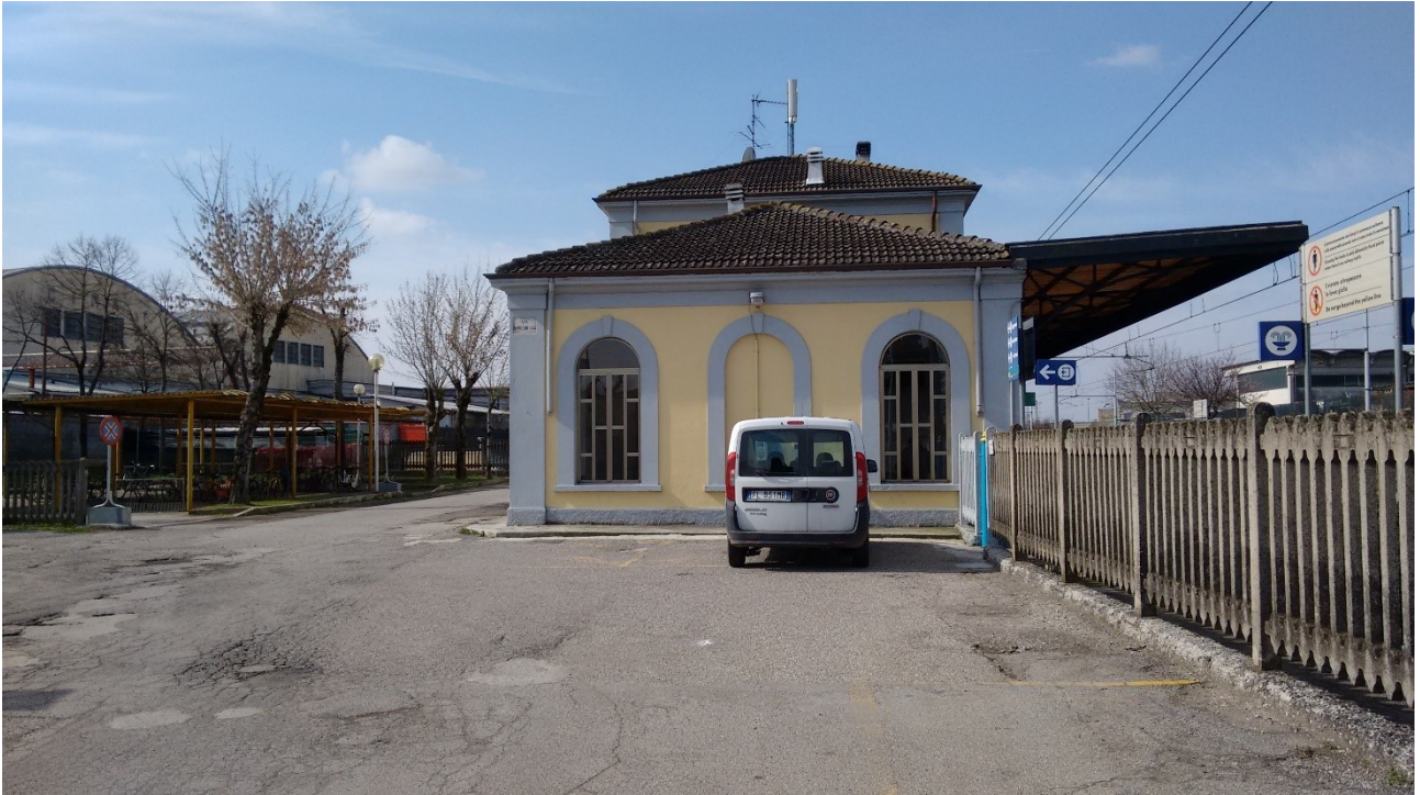
Stato di fatto del piazzale della Stazione di Marcaria (vista laterale)
