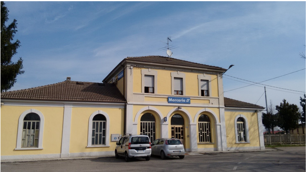
Stato di fatto del piazzale della Stazione di Marcaria (vista frontale)
